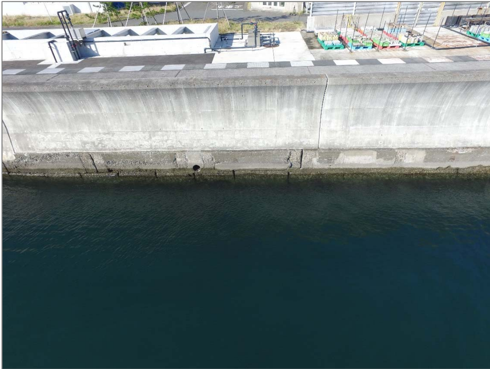
写真-4.8 上部工(波返し) (高度約5m)
