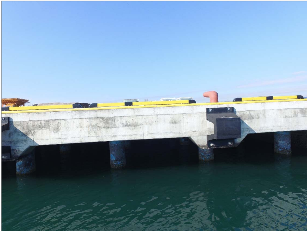
写真-4.17 被覆防食(ペトロラタム被覆, 高度約1m)
