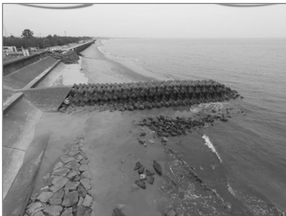
写真-4.28 消波工・根固工(高度約 4m)
