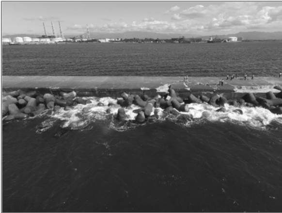
写真-4.9 消波工の一部移動(高度約11m)
