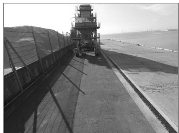
写真-4.12 アスファルト舗装(高度約7m)
