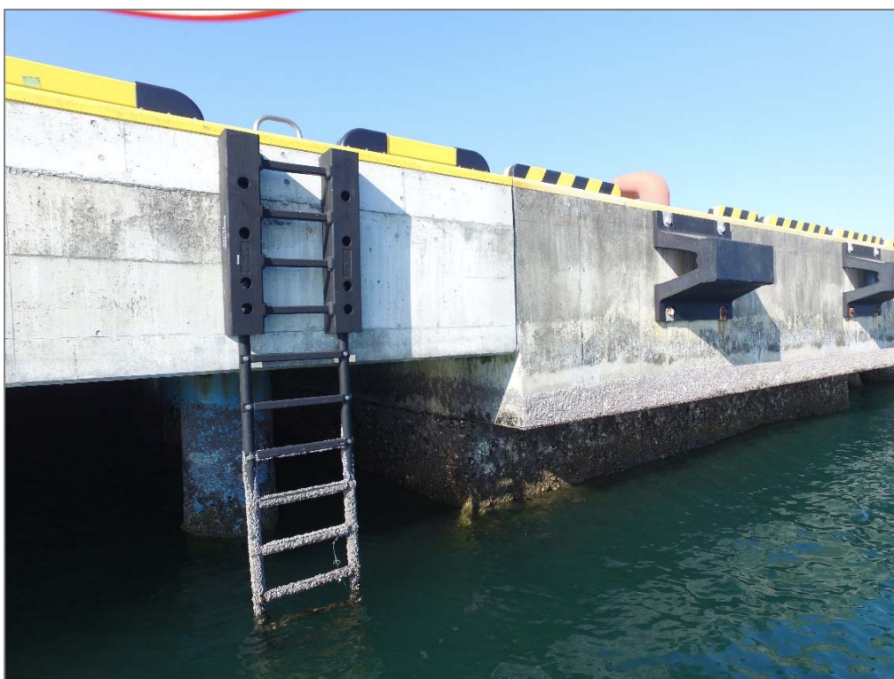
写真-4.16 上部工(左: 棧橋, 右: ケーソン, 高度約1m)
