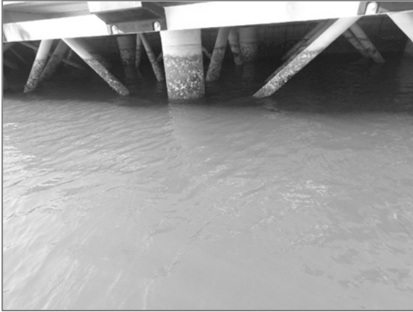
写真-4.18 被覆防食(重防食, 高度約1m)
