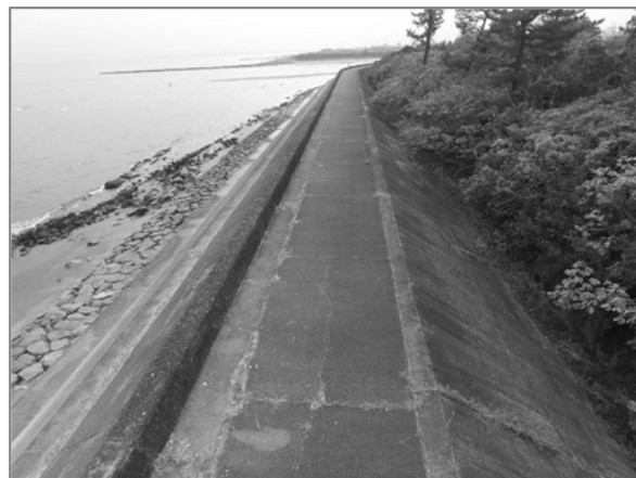
写真-4.23 天端・表法・裏法被覆工 (高度約 7m)
