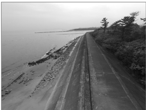
写真-4.22 波返し工 (高度約 8m)
