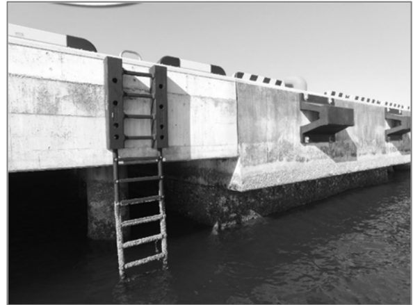
写真-4.16 上部工(左:棧橋, 右:ケーソン, 高度約 1m)
