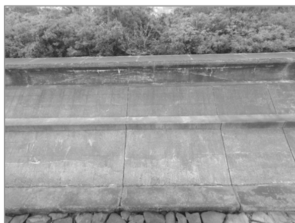
写真-4.25 表法被覆工 (高度約 4m)
