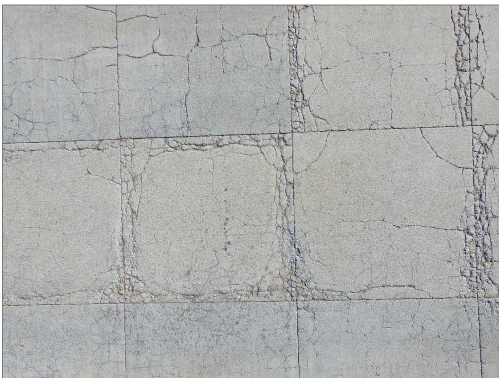
写真-4.15 コンクリート舗装(高度約1m)
