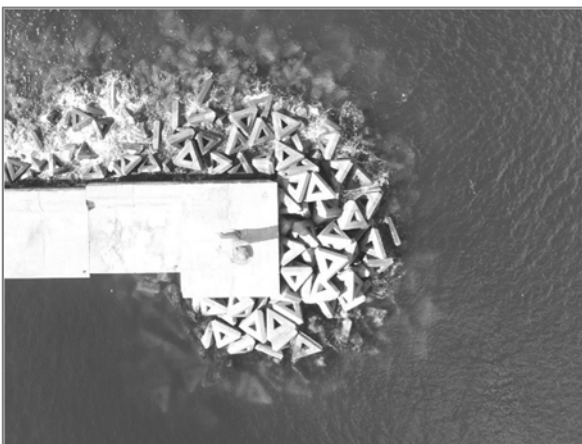
写真-4.10 荒天で被災した防波堤(高度約90m)
