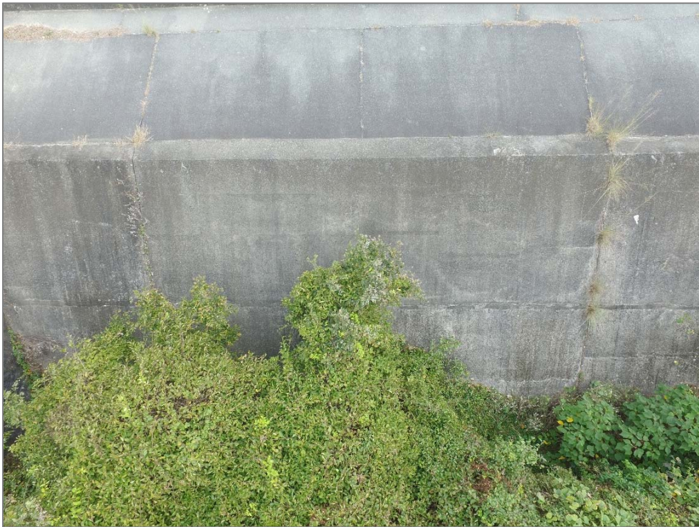
写真-4.26 裏法被覆工(高度約7m)
