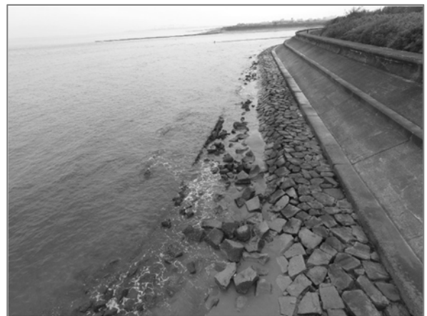
写真-4.31 根固工(高度約 4m)
