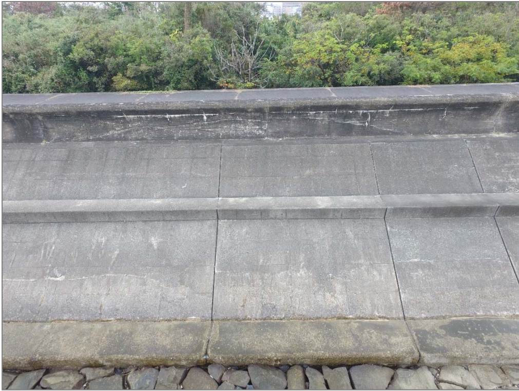
写真-4.25 表法被覆工(高度約4m)
