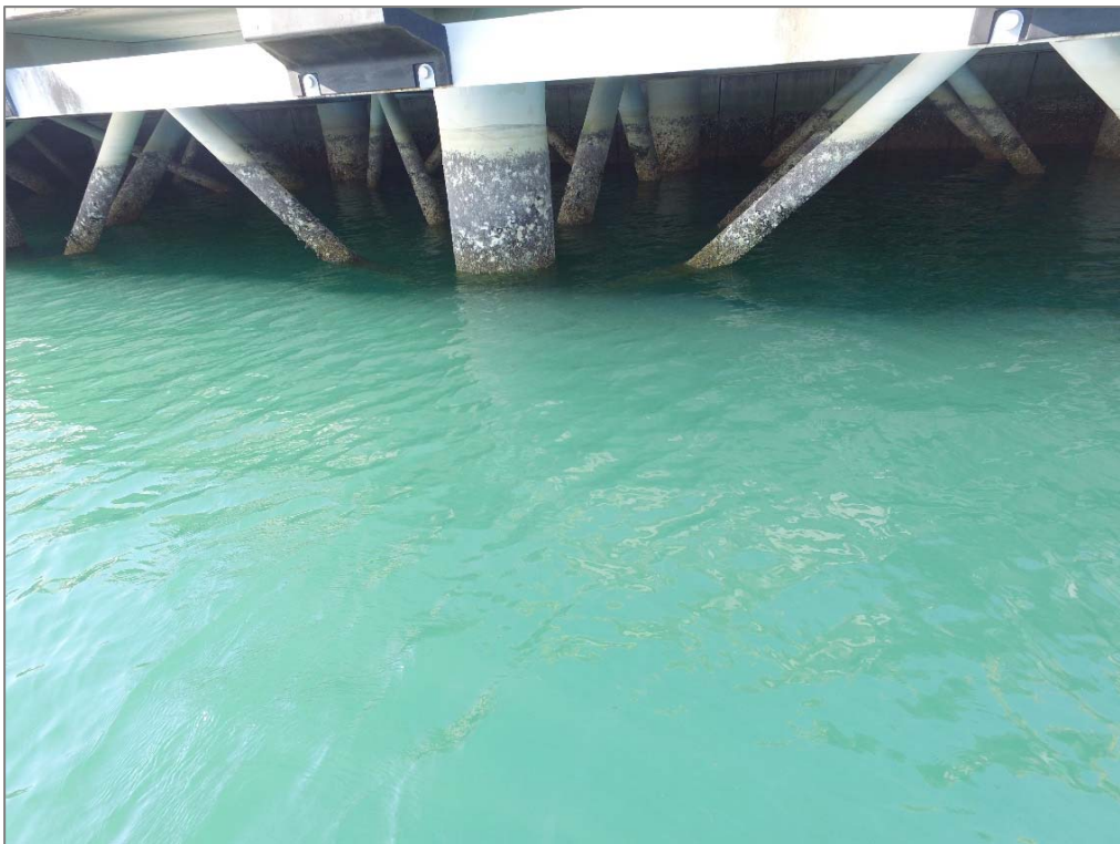
写真-4.18 被覆防食(重防食, 高度約1m)
