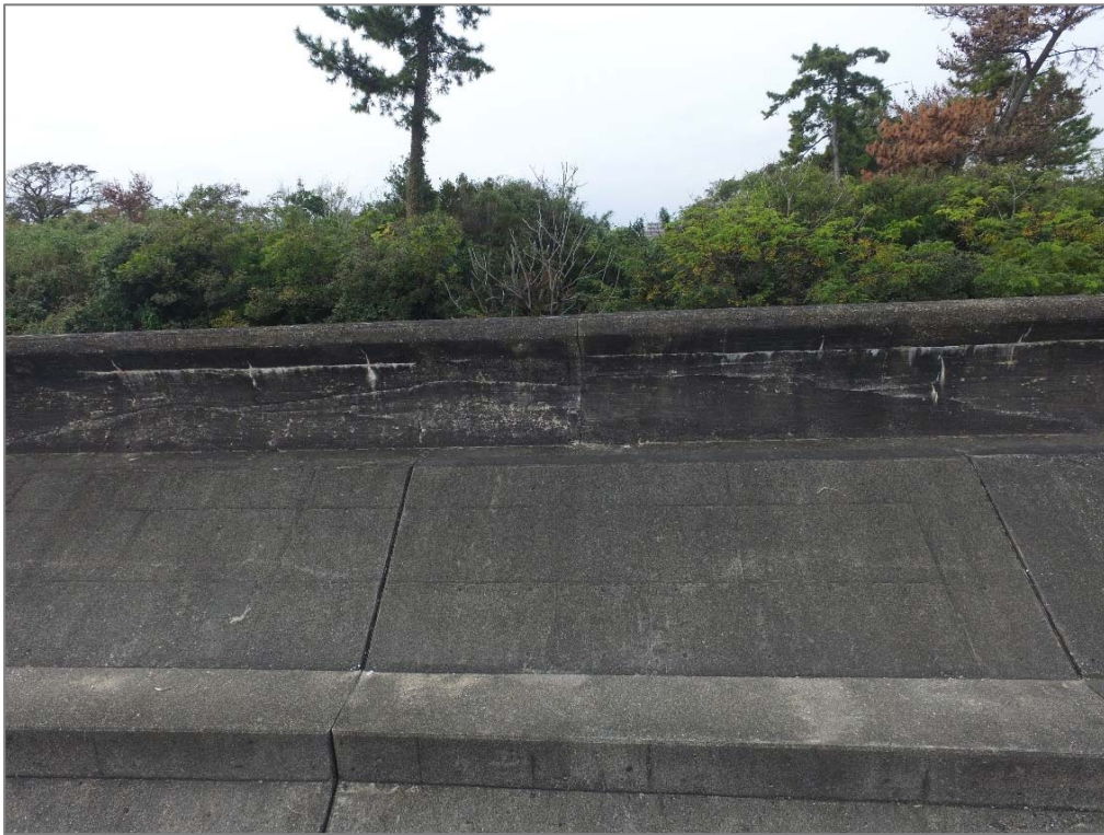
写真-4.21 波返し工(高度約3m)
