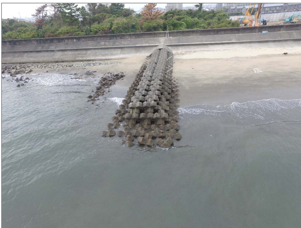
写真-4.30 消波工(高度約6m)
