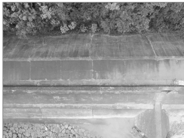
写真-4.24 天端・表法・裏法被覆工 (高度約 16m)
