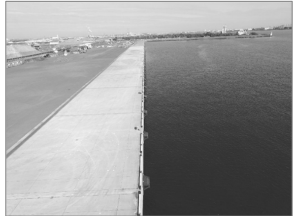
写真-4.11 栈橋の岸壁法線(高度約16m)
