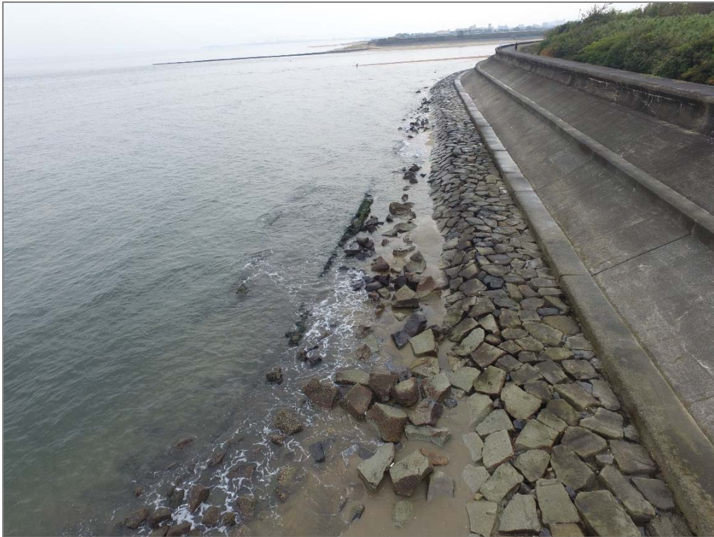
写真-4.31 根固工(高度約4m)
