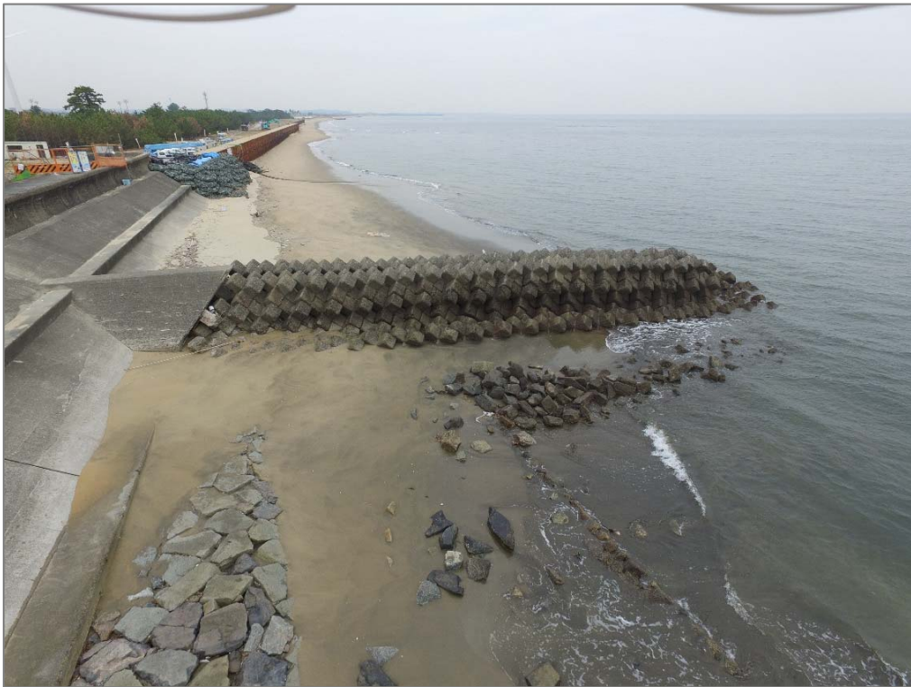
写真-4.28 消波工・根固工(高度約4m)
