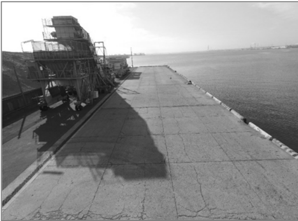
写真-4.14 コンクリート舗装(高度約 9m)
