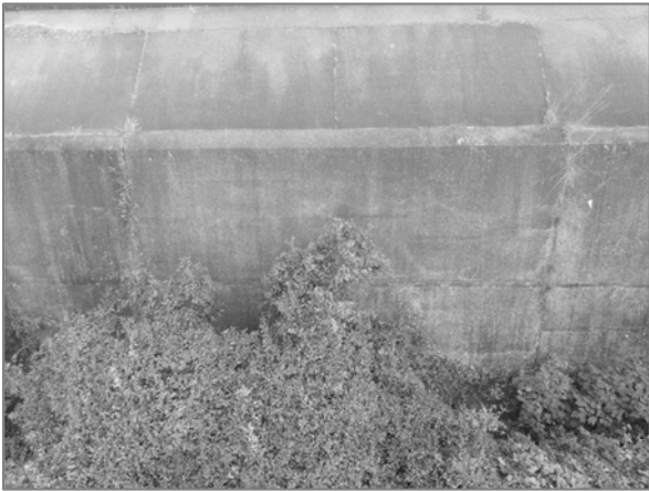
写真-4.26 裏法被覆工(高度約 7m)
