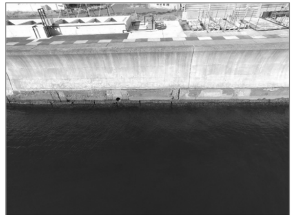
写真-4.8 上部工(波返し)(高度約 5m)
