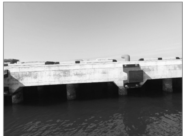
写真-4.17 被覆防食(ペトラタム被覆, 高度約 1m)
