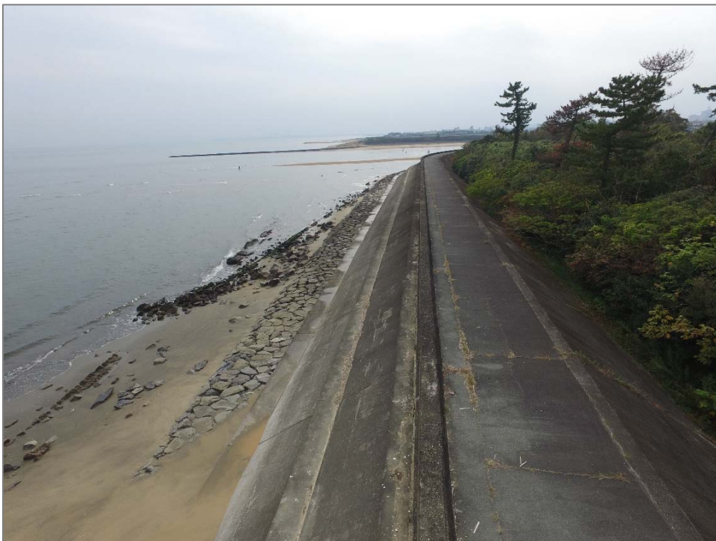
写真-4.22 波返し工(高度約8m)
