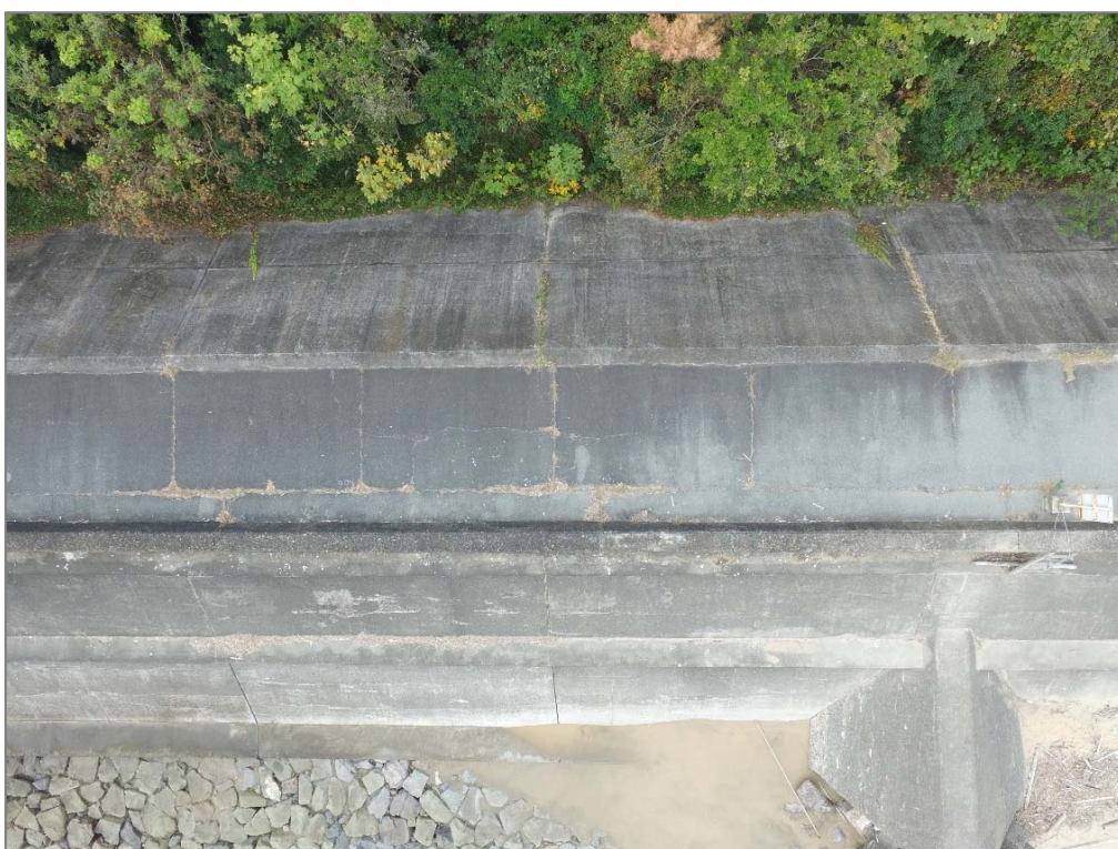
写真-4.24 天端・表法・裏法被覆工(高度約16m)
