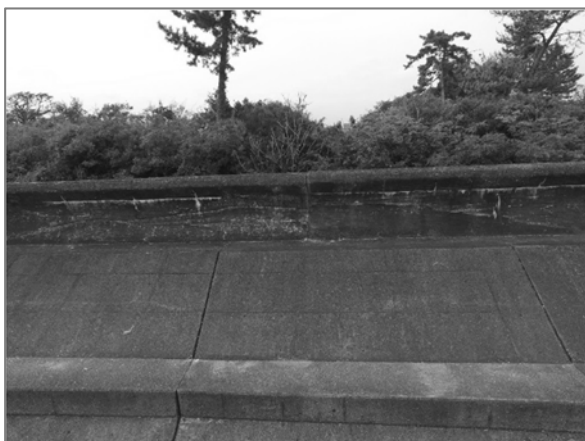
写真-4.21 波返し工 (高度約 3m)
