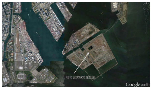
図-2 東京湾中央防波堤外側処分場で実施した杭打設実験の実施位置図（Google earthより）
