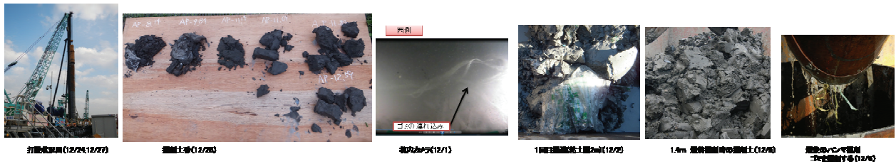
付録図-2.9 試験杭5の施工概況
