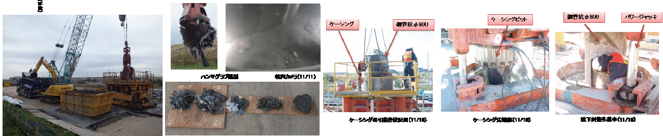
付録図-2.1 試験杭1の施工概況
