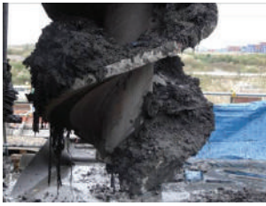
(a) 廃棄物層掘削時
