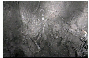
引抜き後の地盤状況 (AP+1.100m) 12/9
