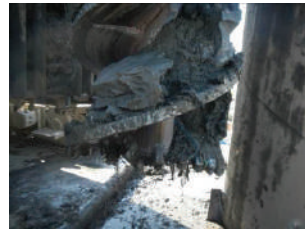
(b) 床付け時（粘土層1m）
