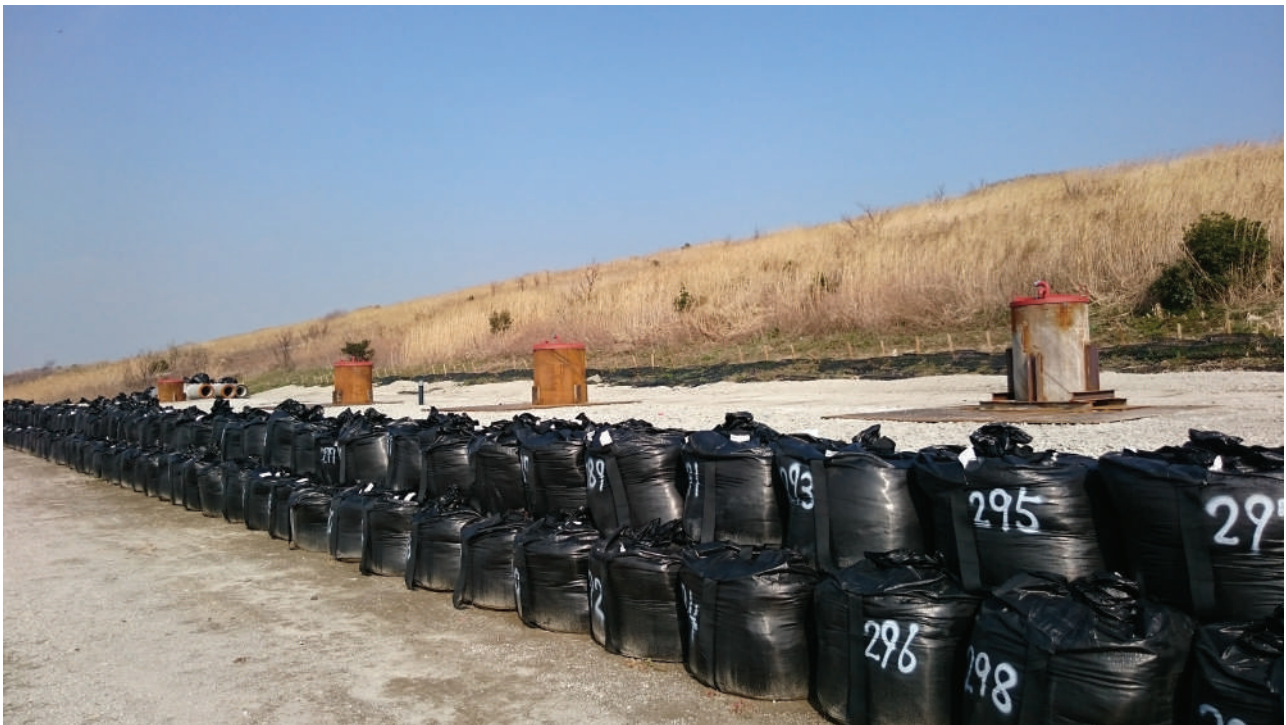
付録写真-1.2 透水試験実施中の現地状況
