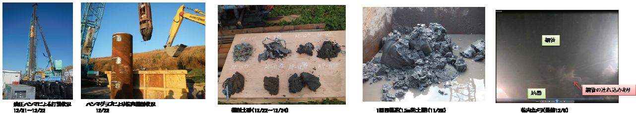
付録図-2.7 試験杭4の施工概況
