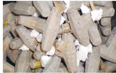
写真-3.4 数個のブロックを撤去した状態（上方より）
