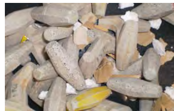
写真-3.5 上層部ブロックを撤去した状態（上方より）
