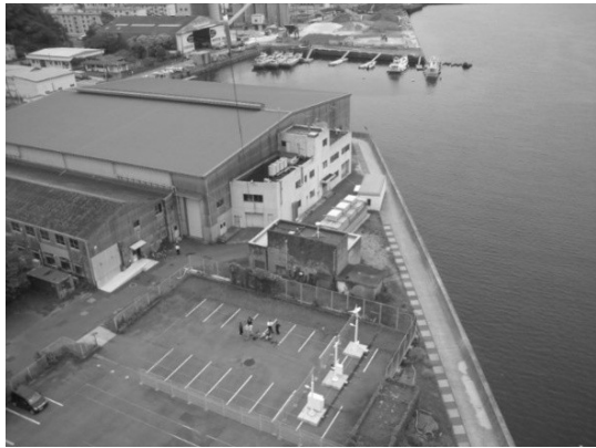
写真-10 スマートフォン化気球空撮システムの画像
