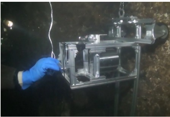
図-7.11 センサ架台固定状況
