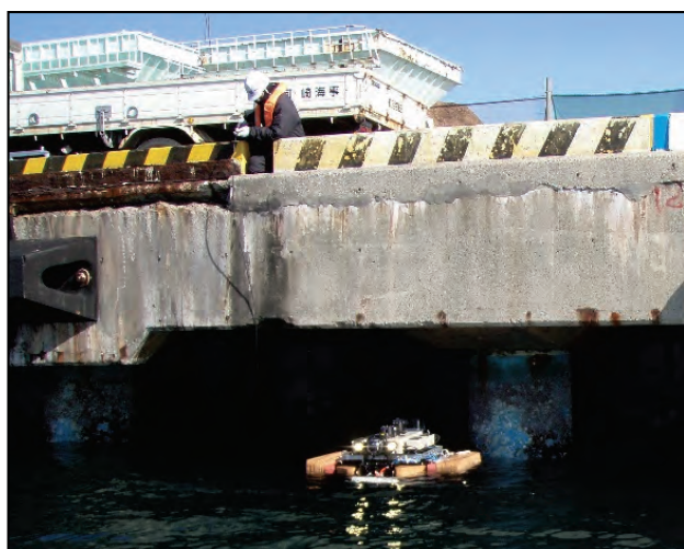
写真-3.5 ケーブル繰り出し状況
