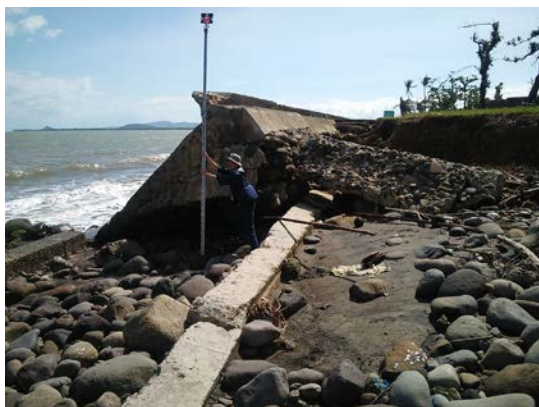
写真-4.4 マッカーサー上陸記念公園の護岸 (第2回調査)
