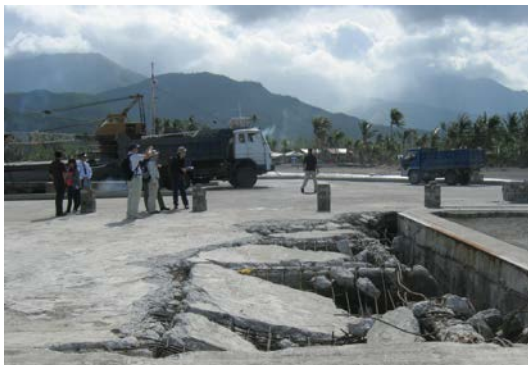
写真-5.37 建設資材を土運船に積み込むダンブ
