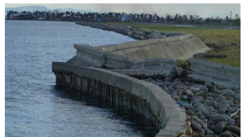
写真-4.2 タクロバン空港の堤防（第1回調査）
