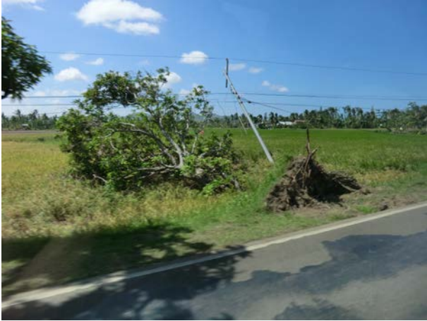
写真-4.16 被害が生じた電柱 (エスタンシア港～クラシ港)
