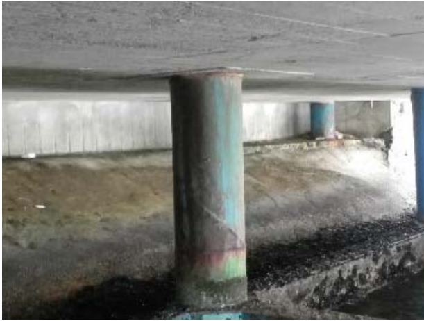
a) 既設鋼管杭 (実験前)
