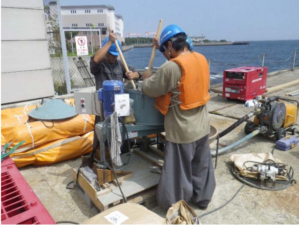
g) UHP-SHCC打設（製造）状況
