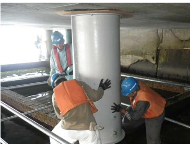
e) 型枠設置状況
