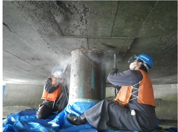
b) 既設上部工はつり状況
