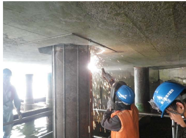
d) 定着鉄筋溶接状況
