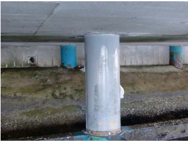
i) 施工完了
