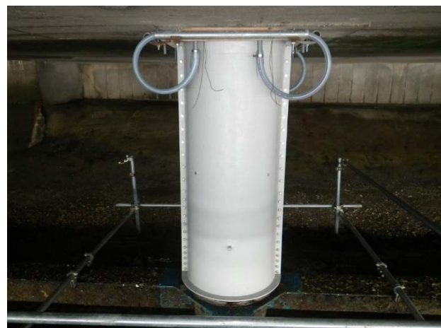
f) 型枠設置完了
