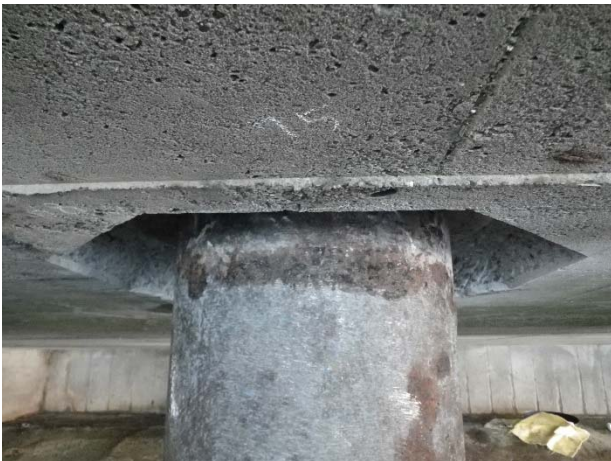
c) 既設上部工はつり完了
