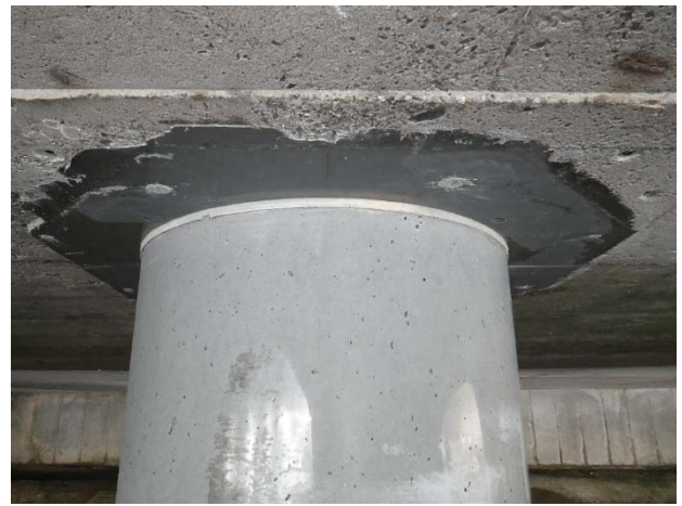
j) 施工完了（鋼管杭頭部）
