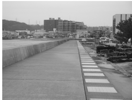
(b) 護岸背後の排水溝
