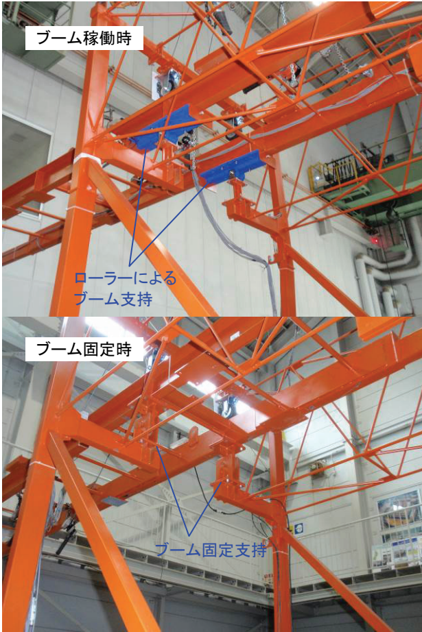
写真-3.3 ローラー支持によるブームの稼働
