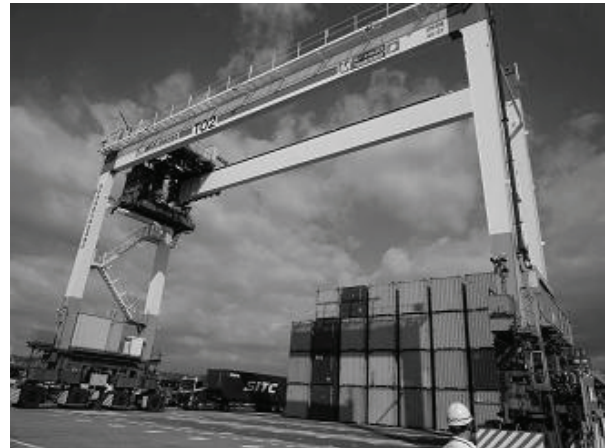
写真-2.1 トランスファークレーン（RTG）
