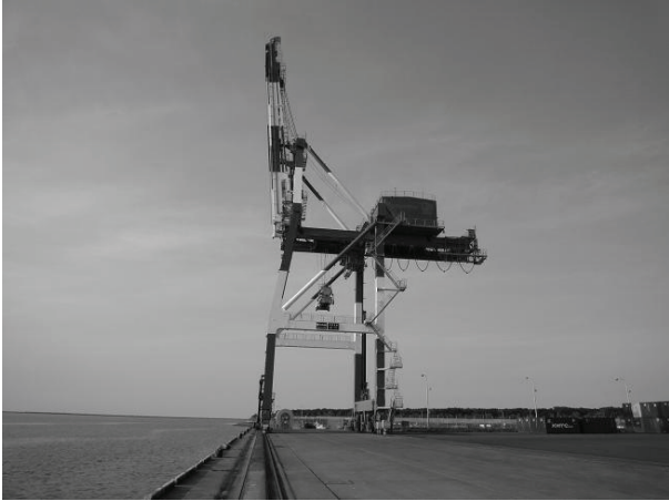
写真-5.3 ガントリークレーン
