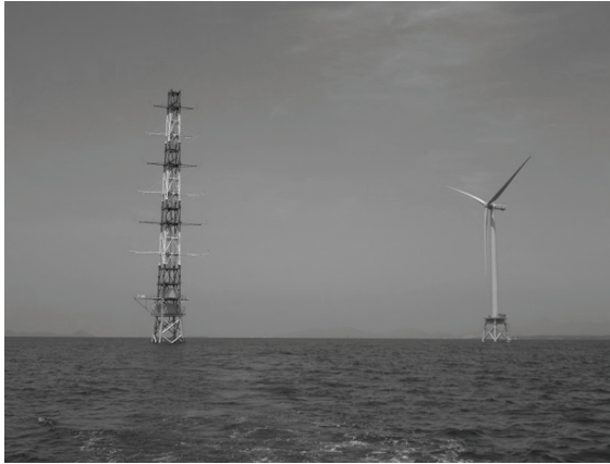
写真-3.1 北九州沖に建設中の洋上風観測塔と洋上風車
