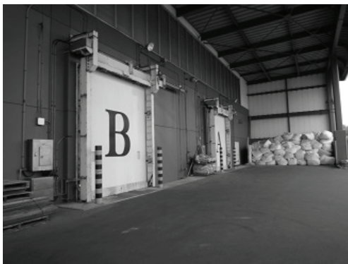
写真-A.1 上屋施設
