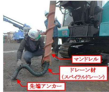
写真-7.5 ドレーン材のマンドレル内セット状況
