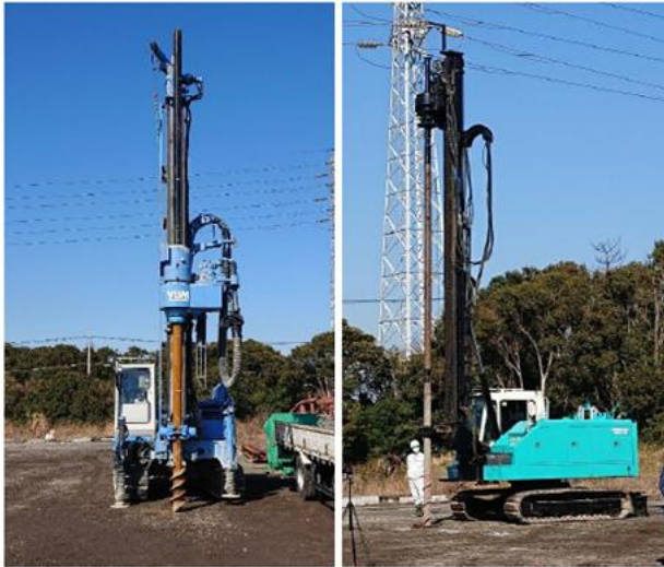
写真-7.3 2種のドレーン打設装置
