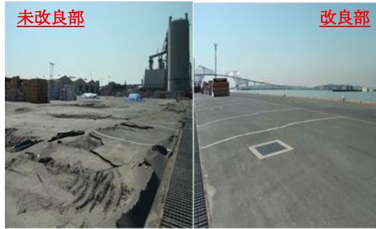
写真-2.2 東北地方太平洋沖地震後の岸壁背後の状況
