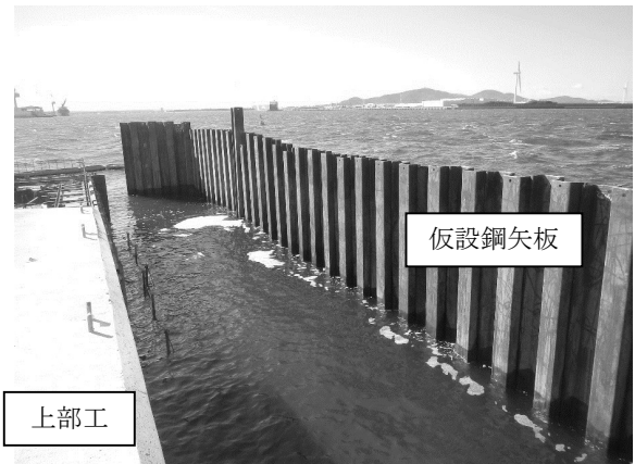
図-B.2 波よけとして設置した仮設の鋼矢板
