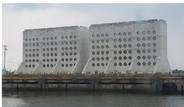
a) 堤体（設置前）
