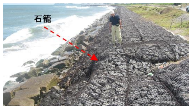
図-1.3 石かごによる護岸の被覆状況
