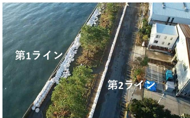
図-1.5 2019年台風15号の応急復旧として2列で設置された土のう 第1ラインは被災したパラペット直背後、第2ラインはガードレール前面に設置された
