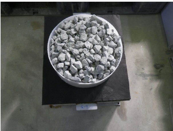
写真-4.4 防砂シートおよび礫材の設置状況
