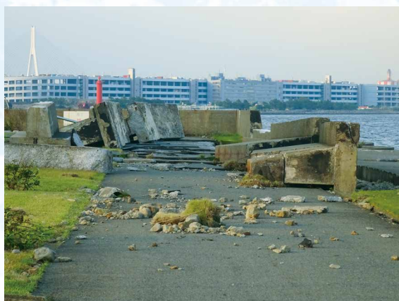
2019年台風15号により倒壊した護岸(横浜港本牧埠頭)
