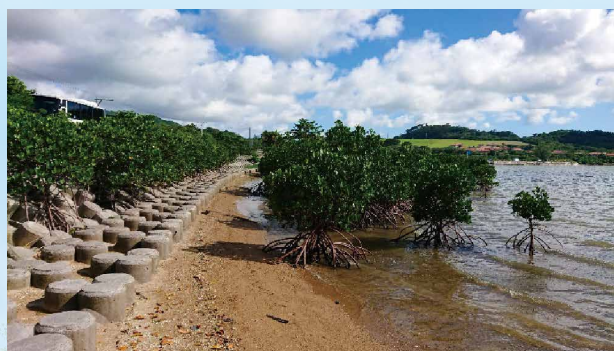
護岸の前にマングローブを植林した例(石垣島) 4)
