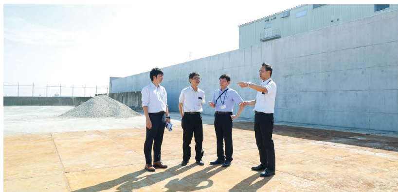
施工が完了した「日の出胸壁」にて（背後の白い壁が完成した胸壁）
