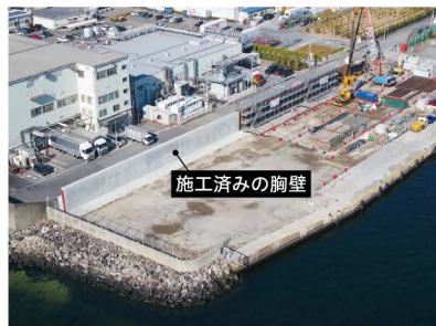
「日の出胸壁」施工状況（右図のA）
