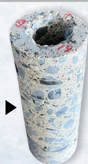
ドリル削孔部のコア採取
