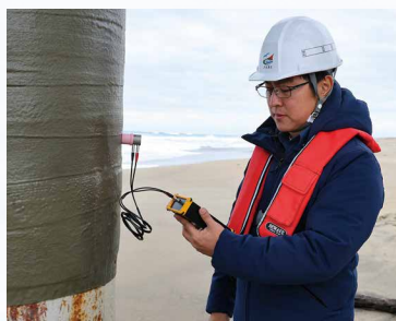
電磁超音波計測装置による鋼管杭の肉厚測定状況
