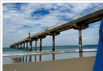
写真2 研究所が所有する波崎観測栈橋。防食に関する現地試験を40年にわたり実施している。
