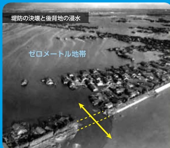
写真1：伊勢湾台風による高潮で決壊した堤防
