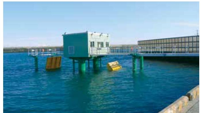
フラップゲート式可動防波堤 実海域実証試験（静岡県焼津漁港）
