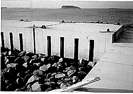
写真-1 両面スリットケーソンを有する護岸の例
