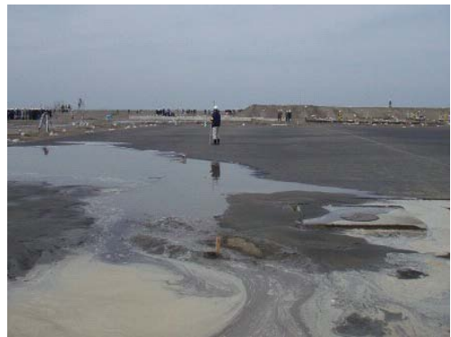
写真-9 発破後の未改良域
