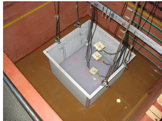
写真-4 ホモゲルによる底面の仮止水 (2)
