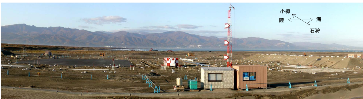
写真-8 実験ヤードの全景
