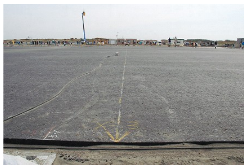
写真-10 発破後の改良域
