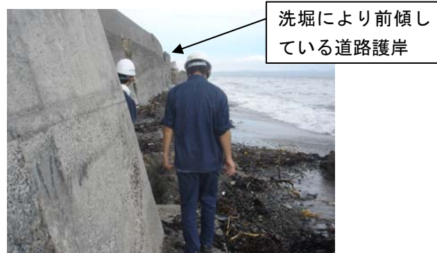
野比海岸の崩落した護岸を調査する 研究所の研究者
