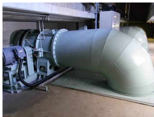
写真-4.1.1.4 水理模型実験水槽の潮流発生装置
