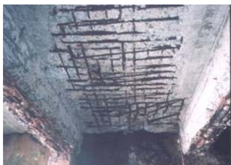
写真-2.1.4.3 棧橋上部工の劣化事例
