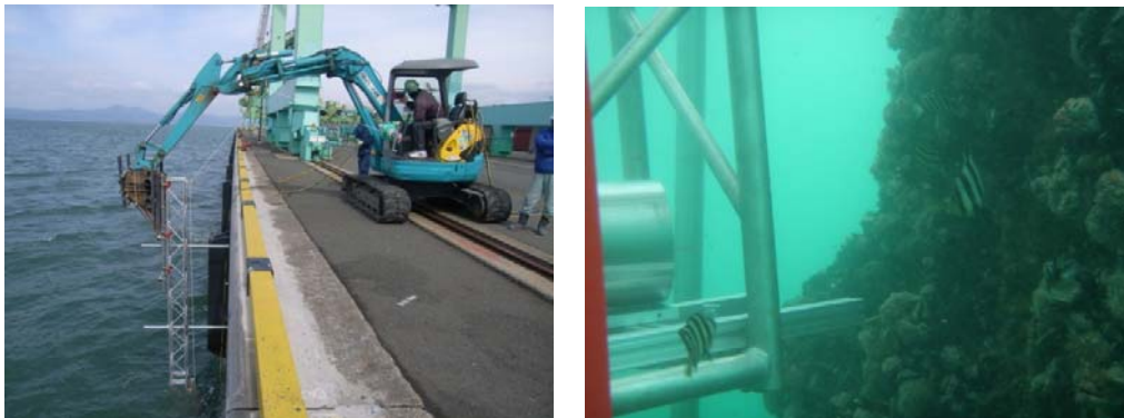
写真-2.1.1.20 八代港等における非接触肉厚計測技術実海域試験(平成 22 年 2 月 16 日)
