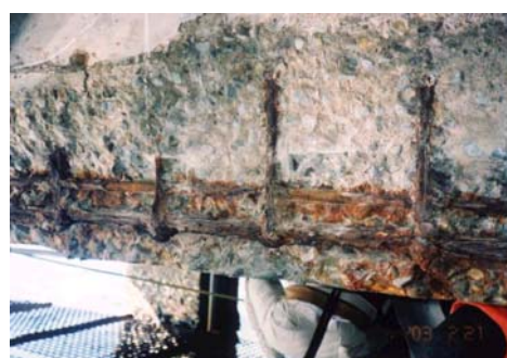
写真-2.1.4.3 棧橋上部工の劣化事例
