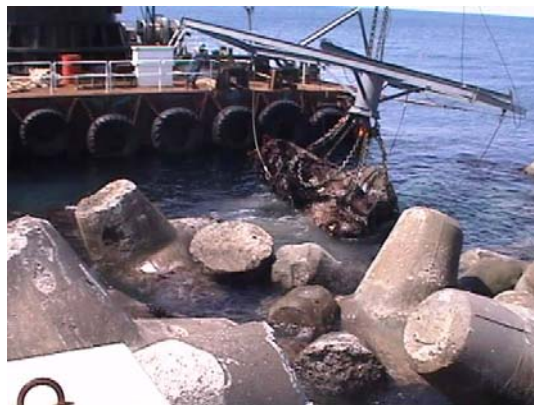
写真-2.1.1.22 消波ブロックの回収(留萌港)
