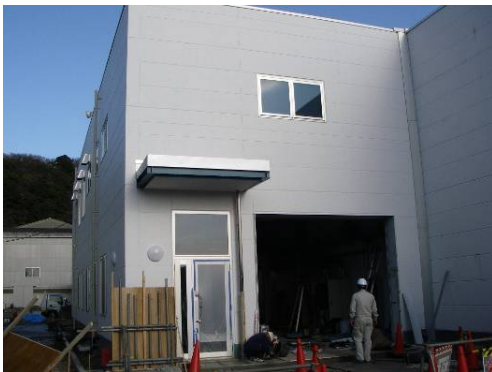
環境水理実験棟外観
