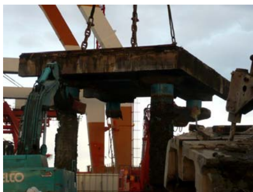
写真-2.1.1.18 内部鉄筋の劣化メカニズム解明のための実構造物からの試験体採取状況
