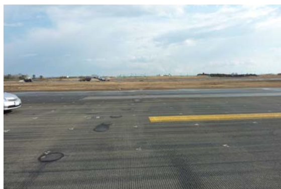
写真-2.1.1.6 仙台空港 液状化対策が効果を発揮(左)
