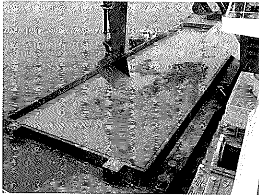
写真-4 浚渫土の圧送船への揚土
