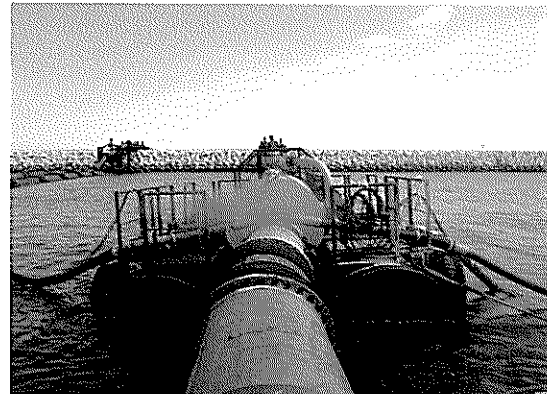
写真-7 排砂管への固化材の供給
