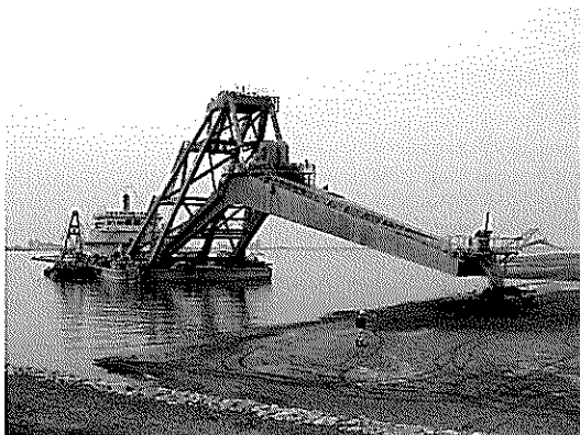
写真-8 固化処理土の打設状況
