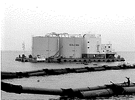
写真-6 固化材供給船
