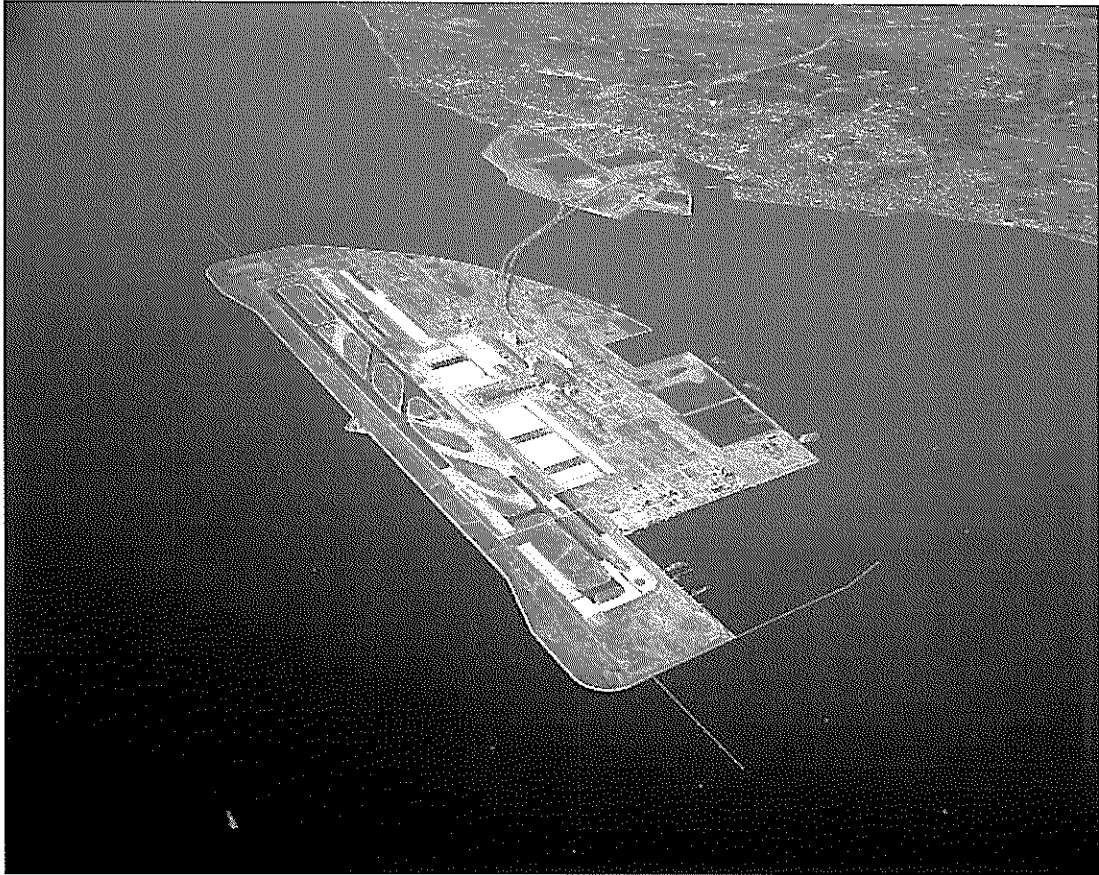
写真-1 中部国際空港の建設状況 (2003.8.22)
