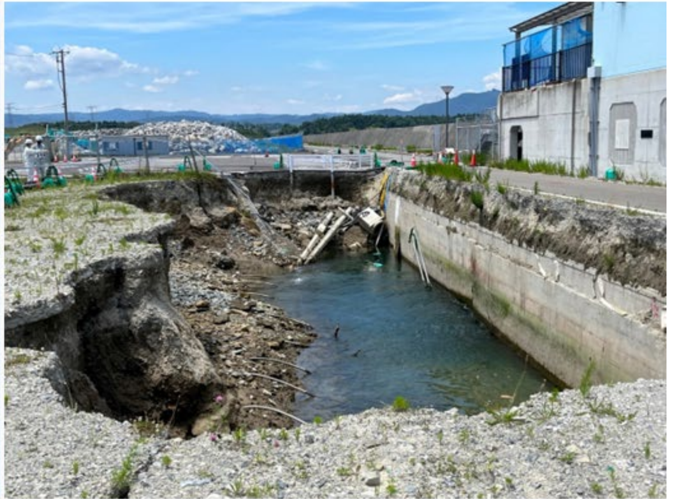
高波・高潮・流れなどの水理外力とともに、 地震動などの多様な動的外力下で大規模な 陥没が発生する
