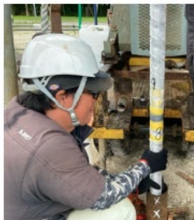
照合電極挿入管設置状況
