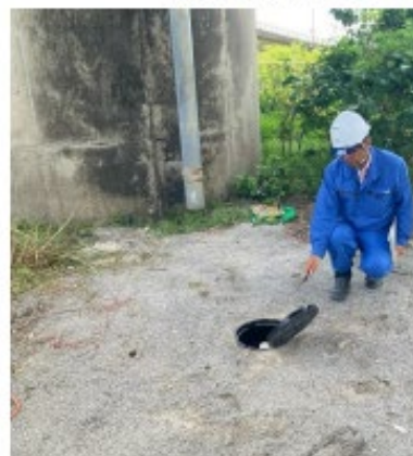
照合電極挿入管設置状況
