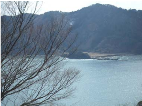
写真-12 大船渡湾口防波堤基部
