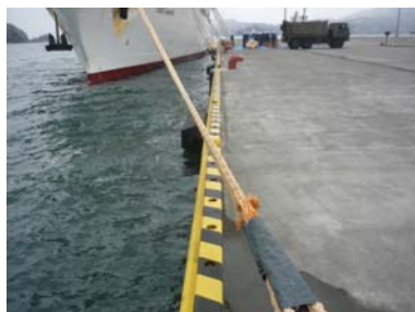
写真-7 -11m岸壁法線（異状なし） 背後との段差（10cm程度） ハーバークレーンの状況
