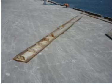
写真—1 4 岸壁法線の状況（異常なし） 外れた鋼製渡版
