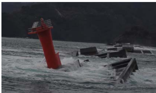
写真-5 釜石湾口防波堤 散乱した北堤の一部
