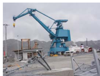
写真-7 -11m岸壁法線（異状なし） 背後との段差（10cm程度） ハーバークレーンの状況
