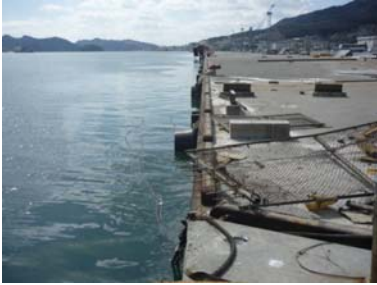
写真—1 4 岸壁法線の状況（異常なし） 外れた鋼製渡版
