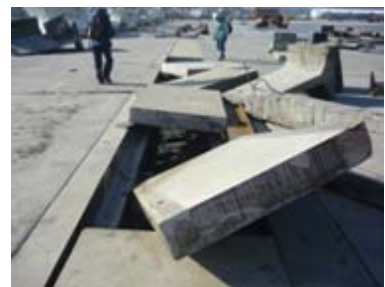
写真—1 6 永浜地区岸壁の法線状況 茶屋前地区渡版の外れ（-6m岸壁）
