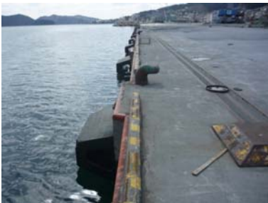
写真—1 5 岸壁法線の状況（異常なし）
