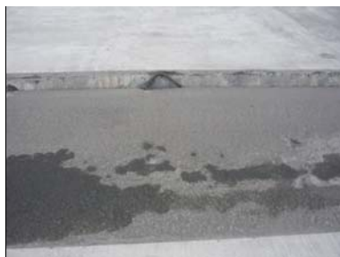
写真-7 -11m岸壁法線（異状なし） 背後との段差（10cm程度） ハーバークレーンの状況
