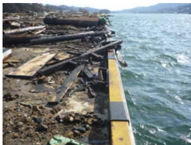
写真—1 6 永浜地区岸壁の法線状況 茶屋前地区渡版の外れ（-6m岸壁）
