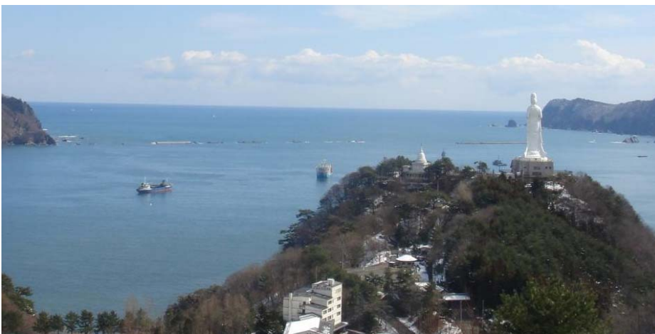
写真-4 釜石湾口防波堤全景
