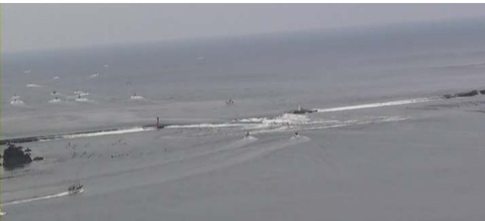
3時13分 防波堤からの均一な越流
