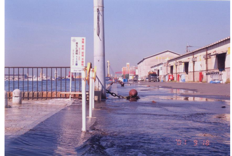
大潮満潮時に岸壁が浸水
