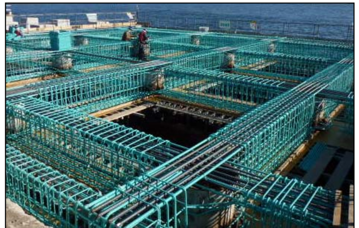
LCMを考慮した栈橋上部工の工事状況
