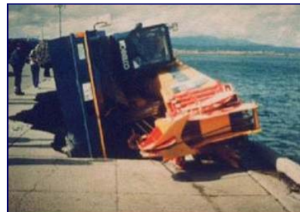
空洞化によるクレーンの転倒
