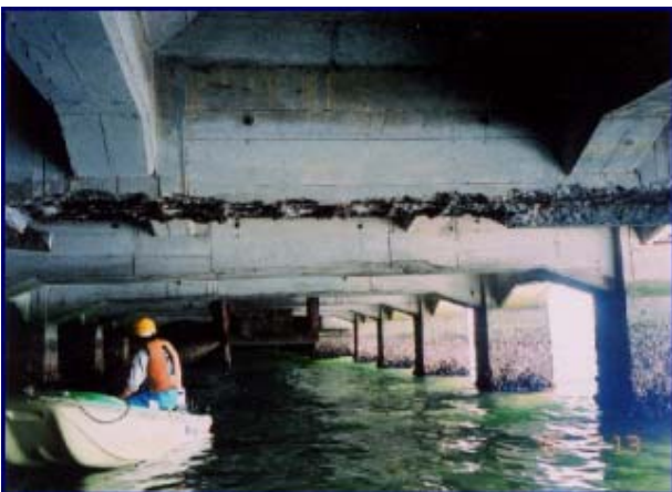
栈橋下での目視点検状況
