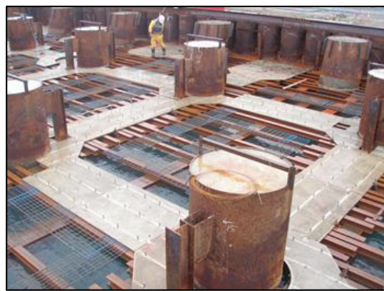
写真-参 3.4 はり底面型枠の設置
