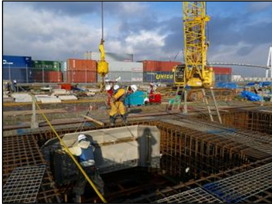
写真-参 3.1 はり底型枠の設置状況
