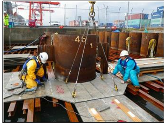
写真-参 3.2 はり側面型枠の組立状況
