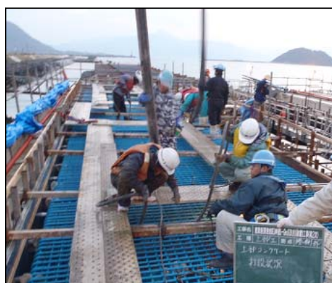
写真-参 1.1 施工状況
