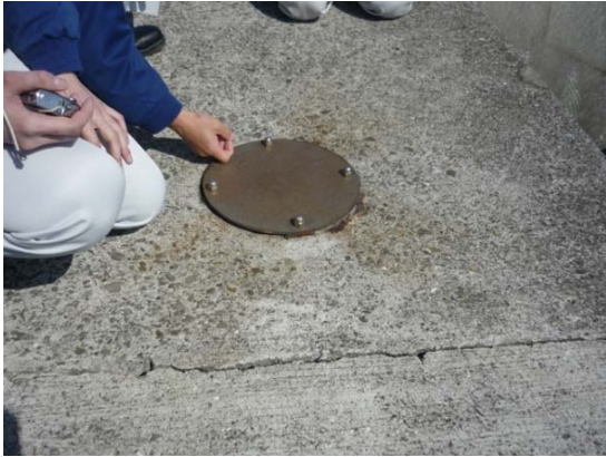
写真-6.1.1 点検孔 (高知港防波堤)
