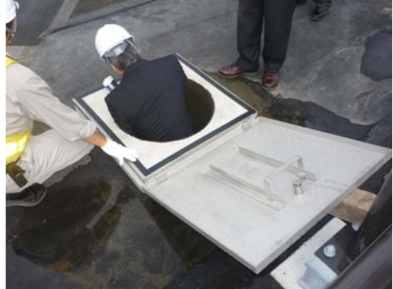
写真-6.1.2 点検孔 (羽田空港 D 滑走路)
