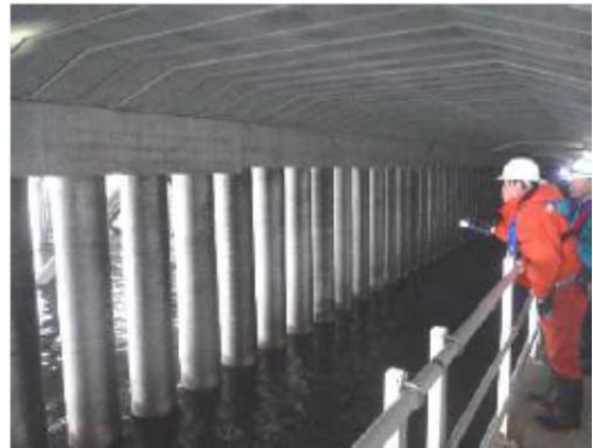
写真-6.1.4 点検歩廊 (羽田空港 D 滑走路)
