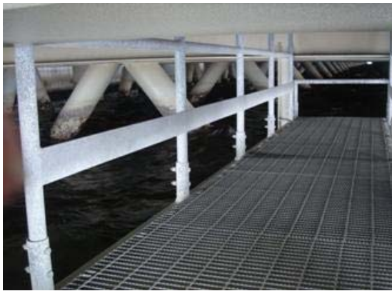
写真-6.1.3 点検足場 (名古屋港飛島埠頭)
