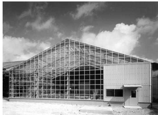
図-2 干潟実験施設の外観
