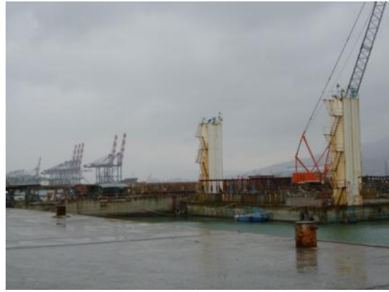
コンテナターミナル進展が進む台北港
