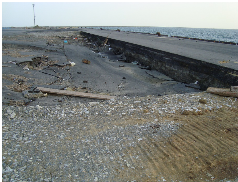
図-9 東北地方太平洋沖地震後に石巻港雲雀野埠頭で行われた応急的措置
