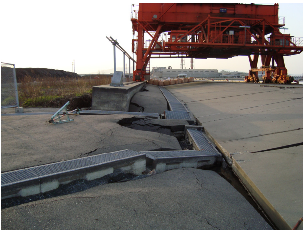
写真-5 小名浜港5号埠頭岸壁 (-12m) 被災状況
