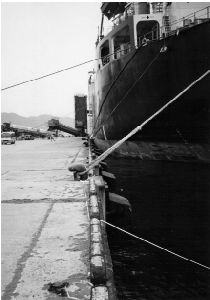
写真-2 境港-13.0m 岸壁の地震後の状況
