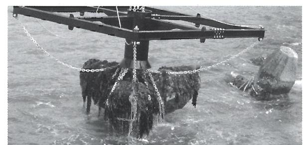
写真2 既設消波ブロック撤去工事
