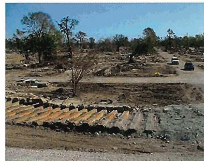
運河の水で押し流されたNinth Wardの住宅地（民家は破壊・流失しており、堤防の矢板が残っていた）
