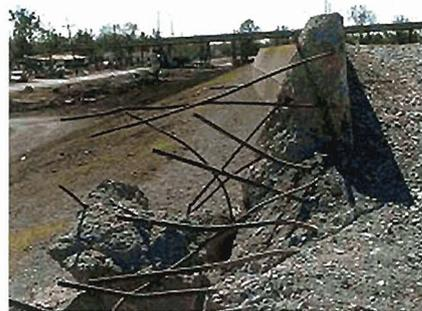
破堤した堤防（復旧中の断面、右側が運河）
