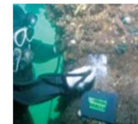
超音波厚さ計による鋼の肉厚調査
