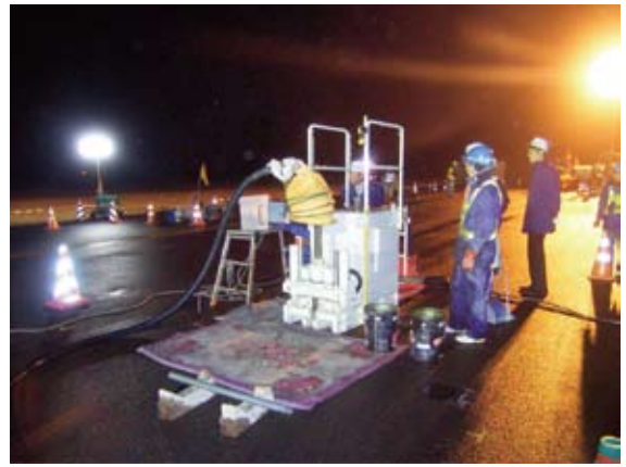
新潟空港における液状化対策工事
