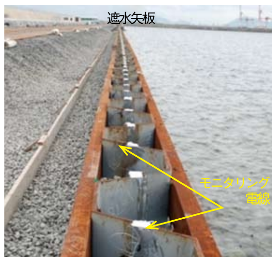
廃棄物海面処分場の遮水工
