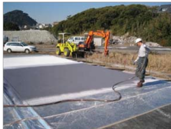
路面温度を低減させる工法の検討を実施した
