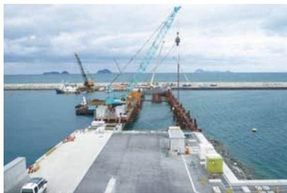
遮水護岸における矢板打設現地実証試験
