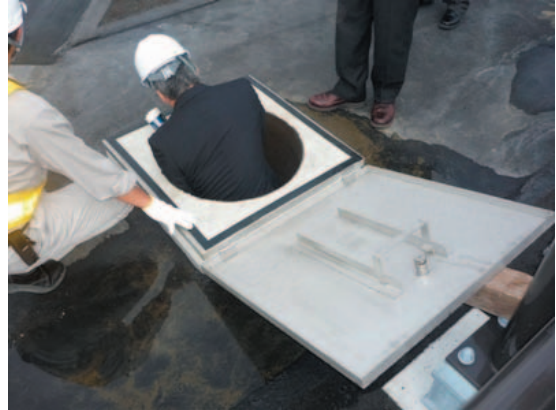
写真-6.1.2 点検孔 (羽田空港 D 滑走路)
