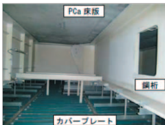
写真-参 2.2 上部工とチタンカバー プレートの間の空間
