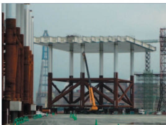
写真-参 2.1 ステンレス鋼被覆を施した ジャケット
