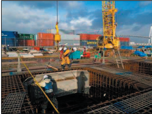
写真-参 3.1 はり底型枠の設置状況
