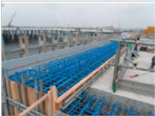
写真-参 2.3 エポキシ樹脂塗装鉄筋の 使用例
