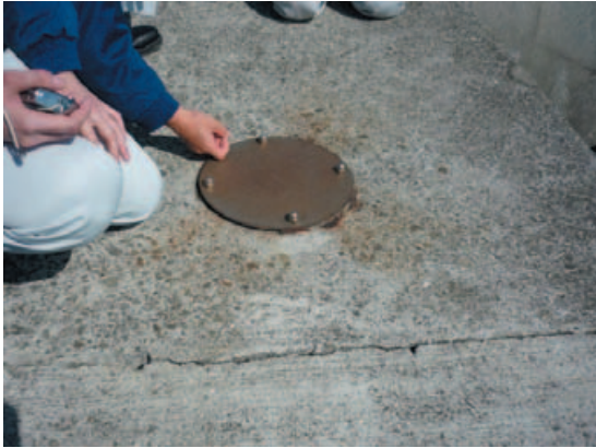
写真-6.1.1 点検孔 (高知港防波堤)
