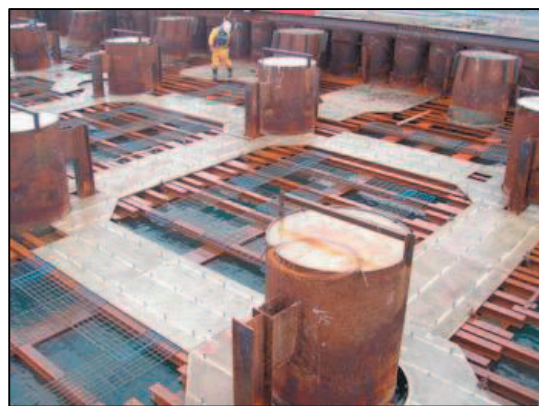
写真-参 3.4 はり底面型枠の設置
