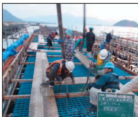
写真-参 1.1 施工状況
