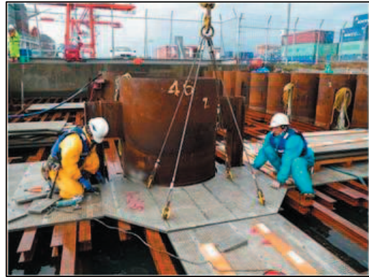
写真-参 3.2 はり側面型枠の組立状況
