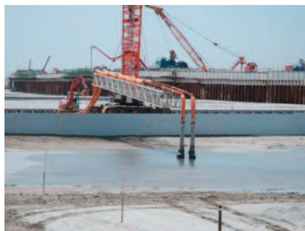
写真-1(c) 羽田空港D滑走路での気泡混合処理土による埋立て状況
