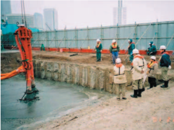
写真-2 気泡混合処理土の打継ぎ部分の様子
