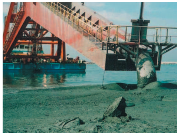
写真-1(a) 中部国際空港での管中混合処理土による埋立て状況
