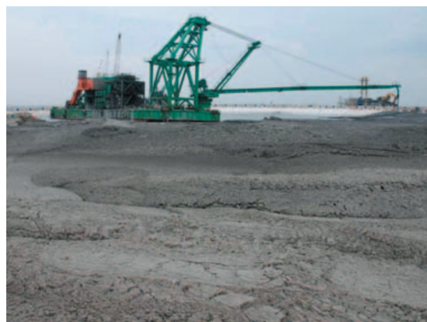
写真-1(b) 羽田空港D滑走路での管中混合処理土による埋立て状況
