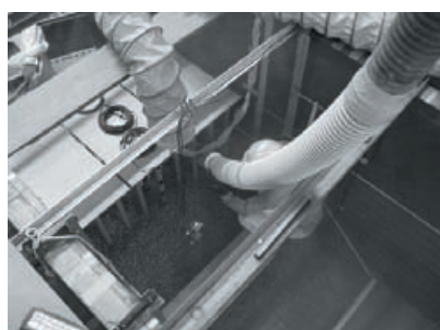
(d) 基礎捨石②の投入
