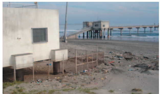
写真-3 新館付近の遡上痕跡
