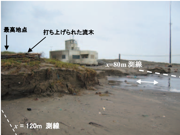
写真-7 浜崖の発生状況 (x=110m付近, 10月7日, 7時頃)
