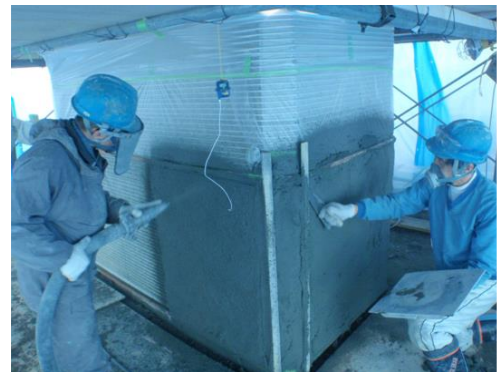
b) 橋脚の耐震補強（吹付け工法）
