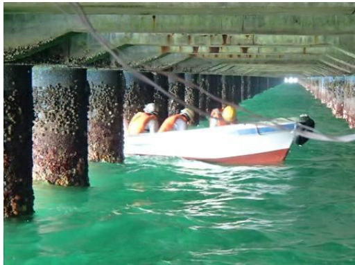
写真-4.1 船外機船での検査
