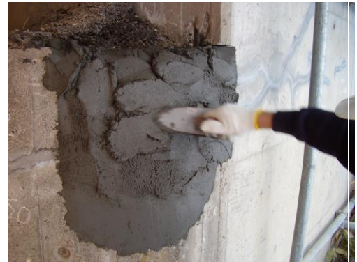
a) 橋台の断面修復（コテ塗り工法）
