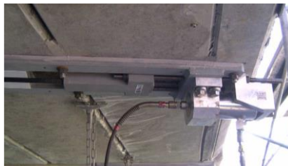
b) PC 橋の橋軸直角方向補強
