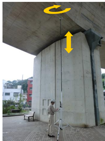
b) PC 橋の支承部の点検調査状況
