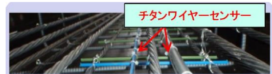
d) 新設構造物(PC桁)への設置
