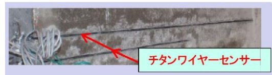
c) 溝切削による設置
