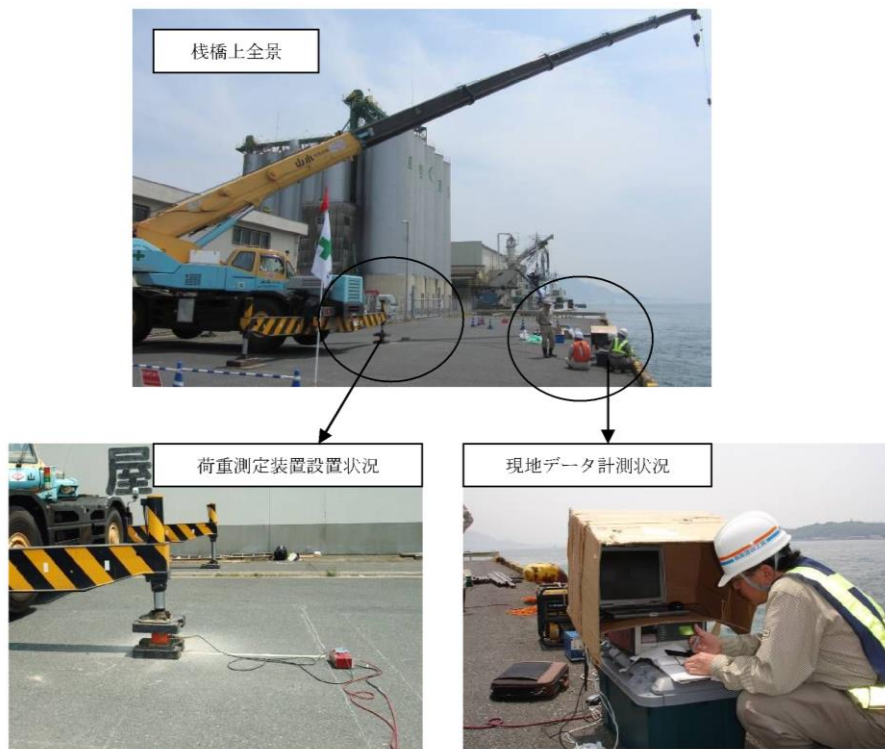
写真-11.7.2 栈橋床版の荷重試験状況 9)
