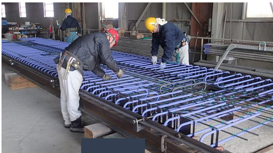
写真-11.2.1 エポキシ塗装鉄筋の組立状況（プレキャストPC床版）
