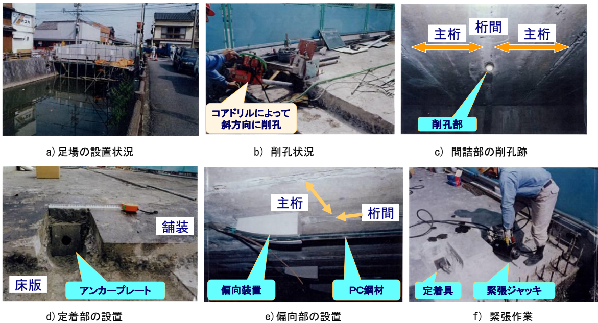
写-付.5.1 OES 工法の施工手順
