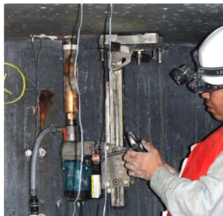
写真-4.3 コア削孔状況
