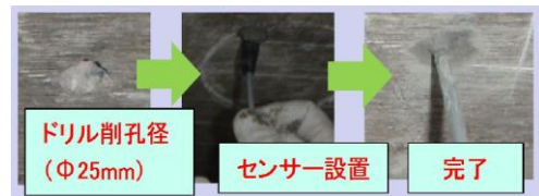
a) ドリル削孔による設置
