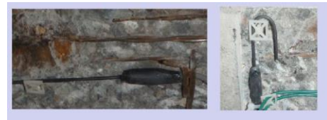
b) 断面修復部への設置
