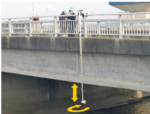
a) PC 橋の主桁部の点検調査状況
