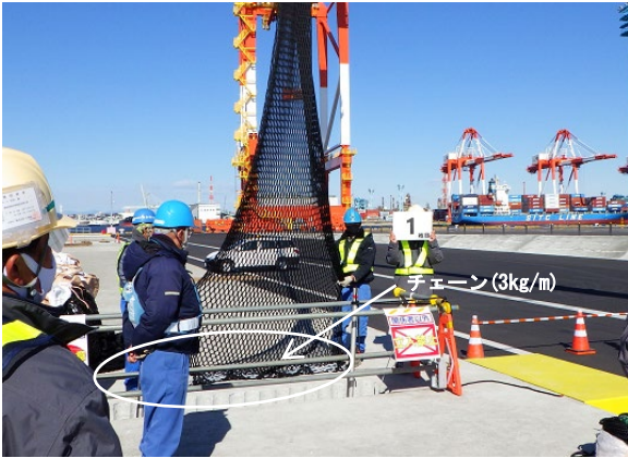
写真-B.13 ネットバッファの敷設
