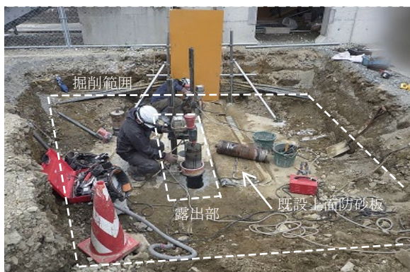
写真-B.49 コアドリリングによる削孔状況
