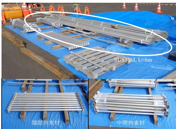
写真-B.10 ガイドパイプ用ステンレス鋼管(上段) 端部拘束材(左下)と中間拘束材(右下)
