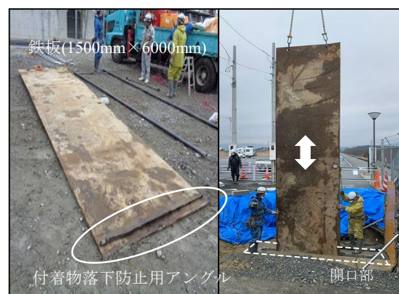
写真-B.51 目地部付着物清掃状況
