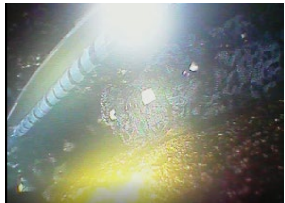
写真-A.20 ネットバッファ水中設置状況
