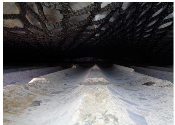
写真-B.38 ネットバッファ設置状況(2)
