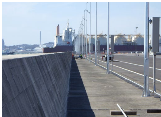
写真-A.1 ネットバッファ工法の施工前状況
