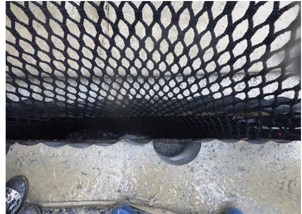
写真-B.58 ネットバッファ設置状況
