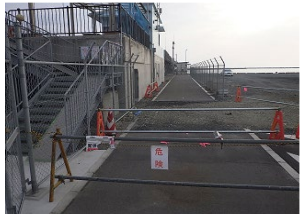
写真-B. 47 施工前
