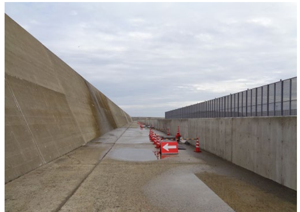
写真-B.25 施工前
