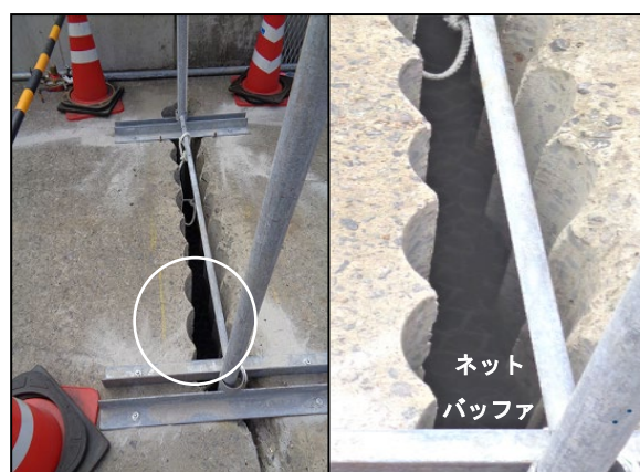
写真-B. 43 仮固定中のネットバッファ工
