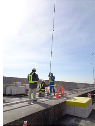
写真-A.10 ケーソン目地部計測（高さ）
