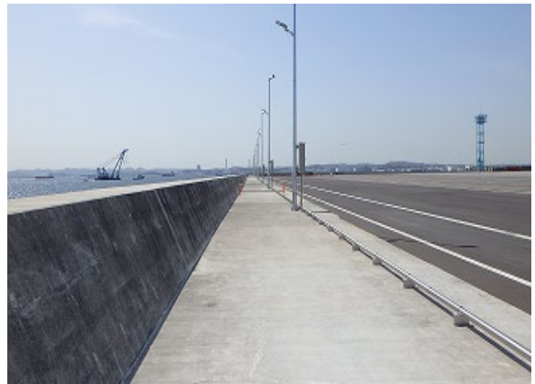
写真-B.1 施工前
