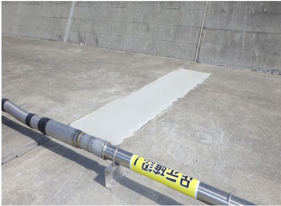
写真-A.21 復旧完了
