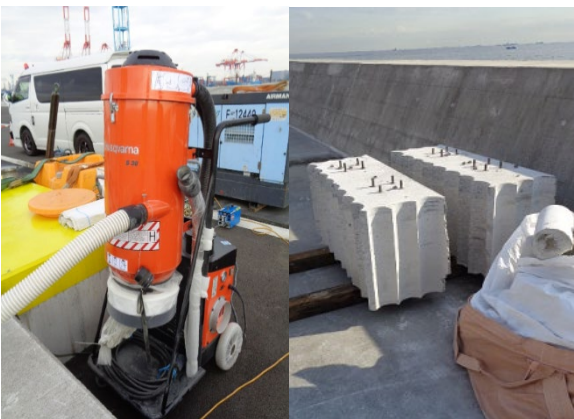
写真-B.4 乾式用バキュームタンク(左)と撤去された上部工の一部(右)
