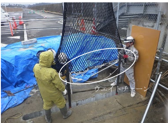
写真-B.57 ネットバッファ設置(1枚目)
