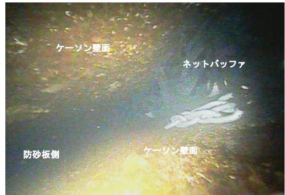
写真-B.22 ケーソン目地に設置したネットバッファ
