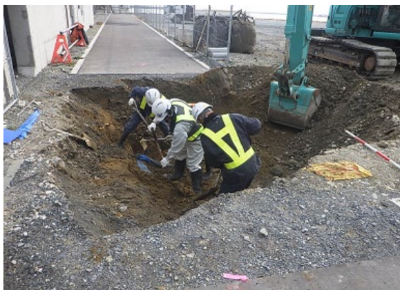
写真-B.48 覆土の掘削状況
