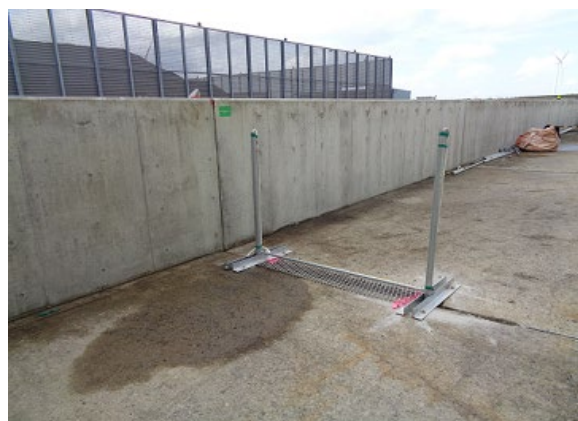
写真-B. 42 ガイドパイプの施工後固定状況
