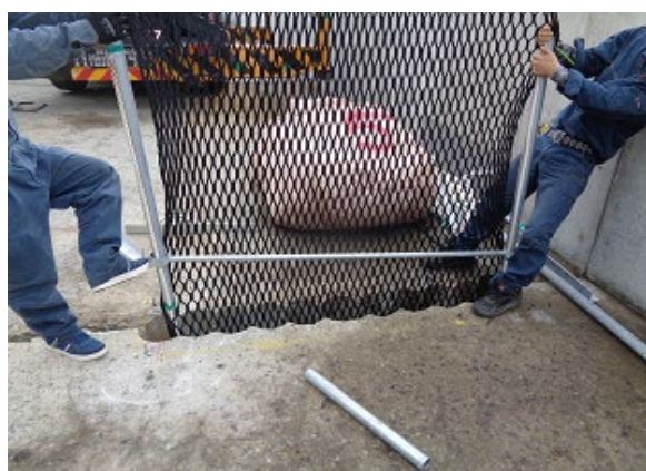
写真-B. 41 中間拘束材の挿入
