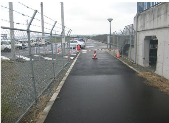
写真-B.62 施工後
