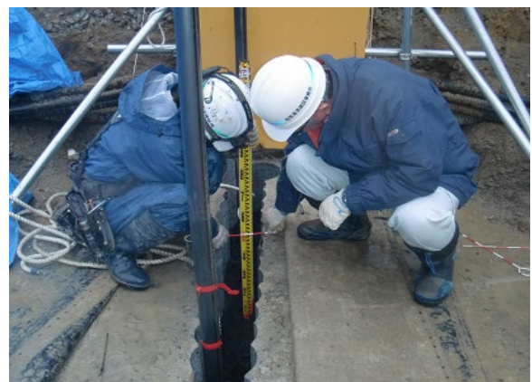
写真-B.59 ネットバッファの挿入高さ確認
