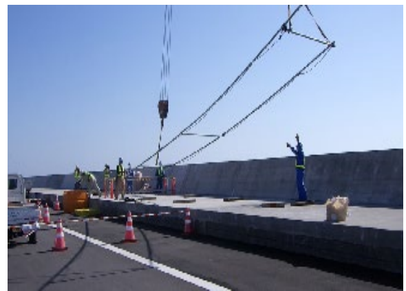
写真-A.12 ガイドパイプの設置
