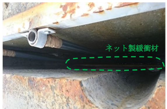
図-2.10 ガイドレールの固定とネット材
