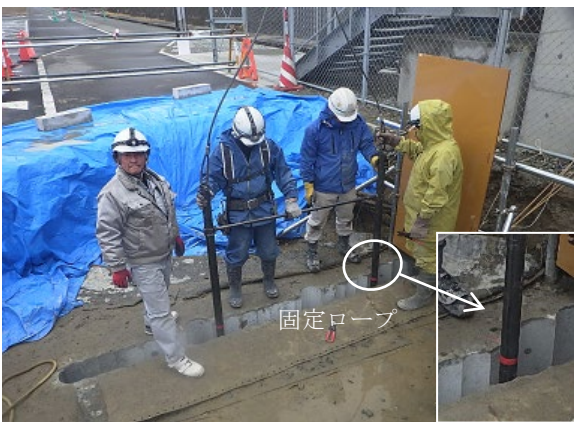
写真-B.56 ガイドパイプ目地部設置状況
