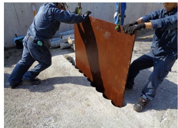
写真-B.30 目地部付着物清掃状況
