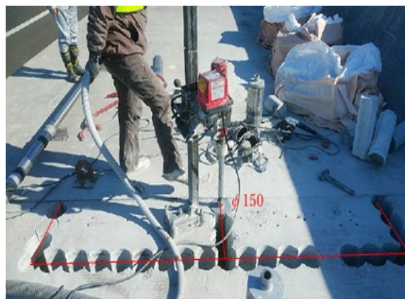
写真-A.2 連続コアドリリングによる削孔状況
