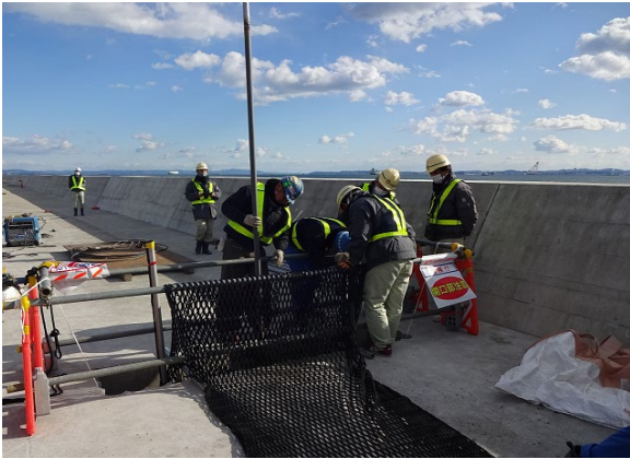
写真-B.18 鋼管等棒状材による詰め込み作業
