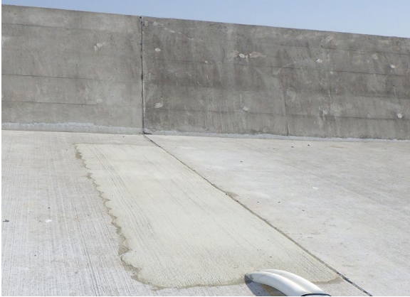
写真-B.23 上部工の復旧
