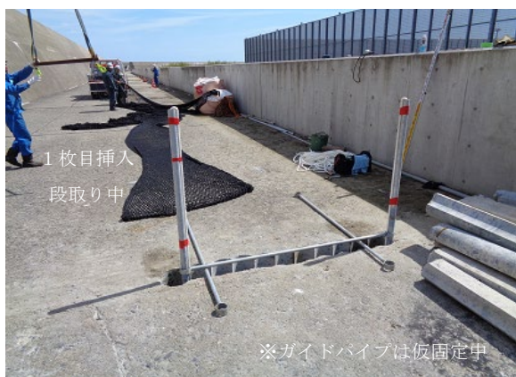
写真-B.35 ガイドパイプ設置状況
