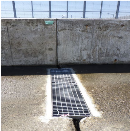
写真-B. 45 グレーチングによる復旧工
