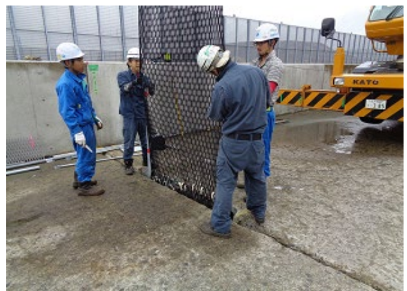
写真-B.37 ネットバッファ設置状況(1)
