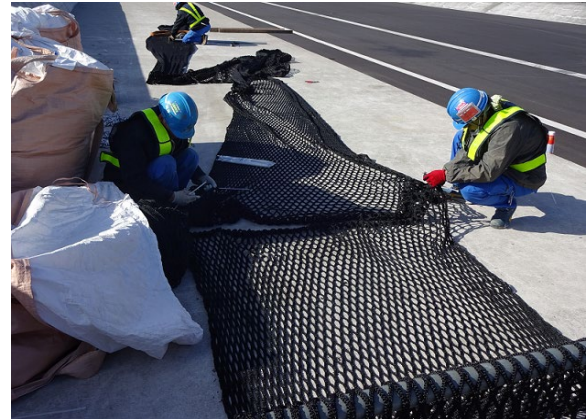
写真-B.15 ネットバッファの接続
