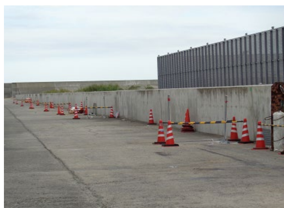
写真-B. 44 ネットバッファ設置後全景
