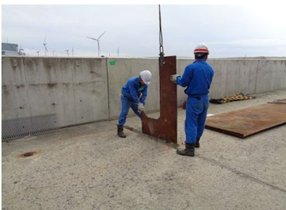
写真-B.28 目地間の障害物撤去
