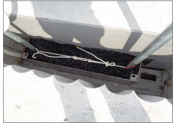
写真-B.21 型枠に詰まったネットバッファ
