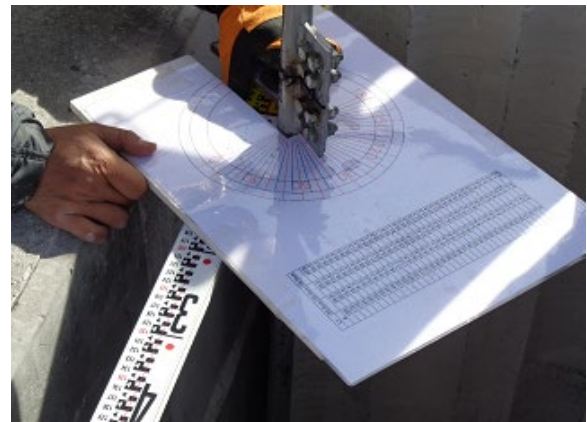
写真-A.11 ケーソン目地部計測（目地幅）
