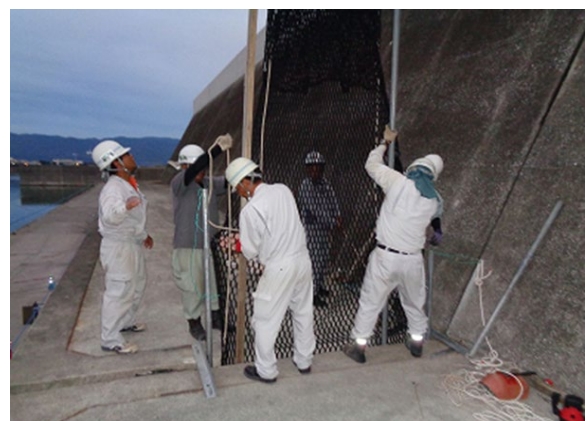
写真-A.16 鋼管等による詰め込み作業
