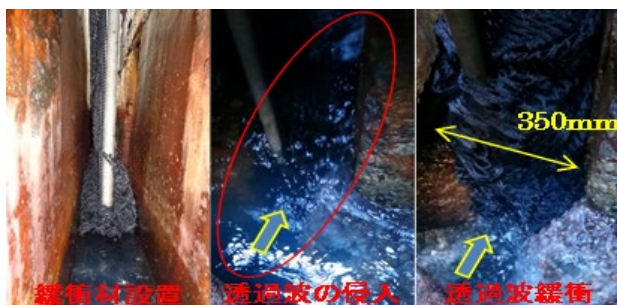
写真-3.1 緩衝材の設置及び緩衝状況
