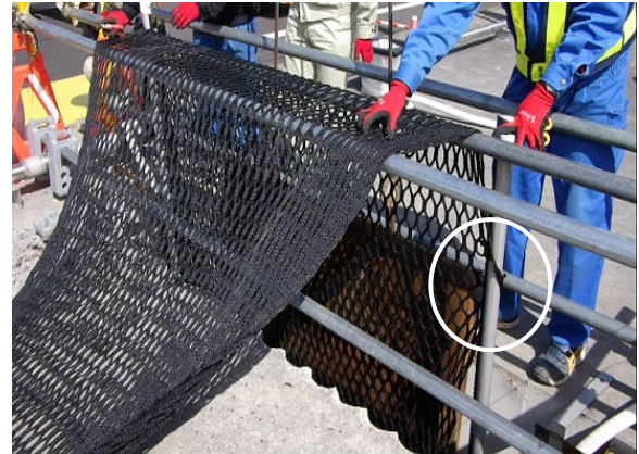
写真-A.14 ネットバッファの挿入
