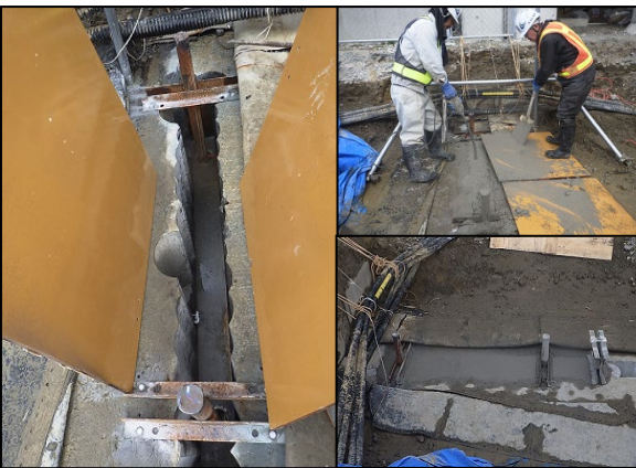
写真-B.61 上部工復旧コンクリート打設
