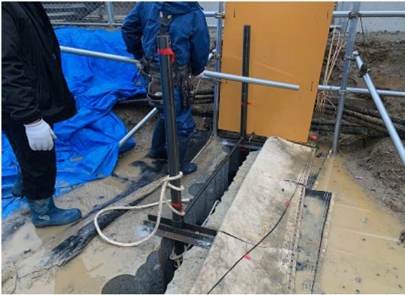
写真-B.60 ネットバッファ設置完了
