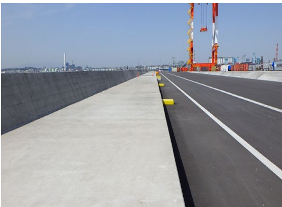
写真-B.24 施工後
