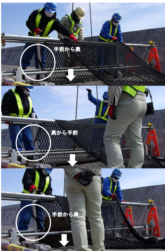
写真-B.14 ネットバッファ設置状況
