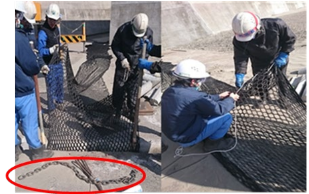
図-2.9 緩衝材の設置状況とウエイトチェーン・ネット材の接続
