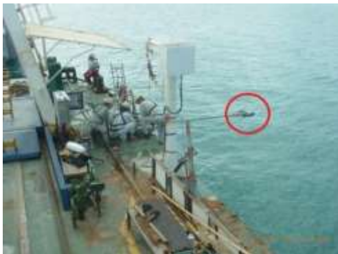
図-5.11 SBL（トランシーバ）設置状況
