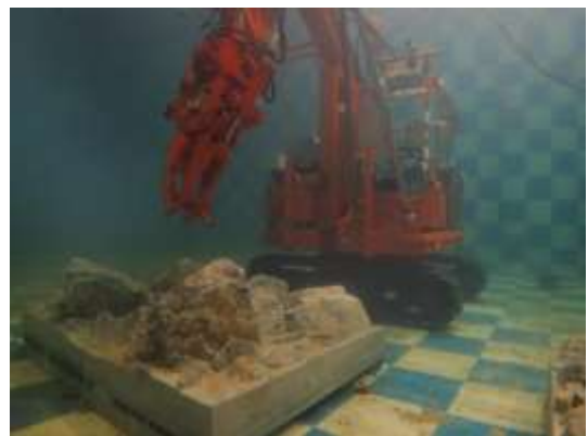
図-3.56 計測試験の状況
