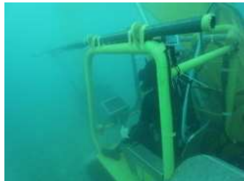
図-5.15 水中作業状況
