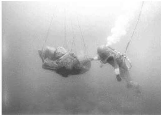
図-2.2 マウンド石材の移設
