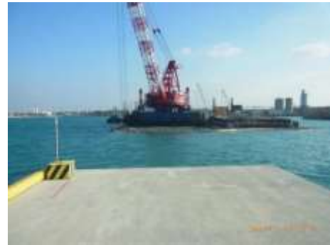
図-5.1 床掘作業中の状況
