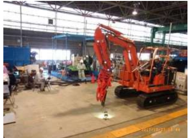
図-4.20 先端座標誤差計測状況
