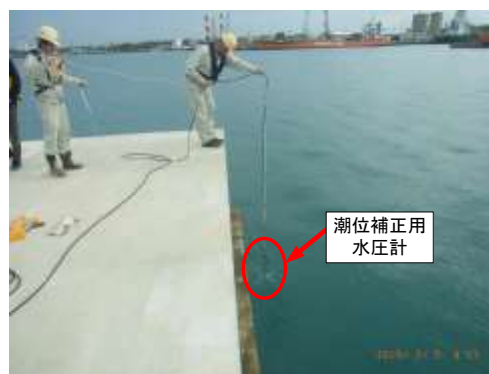
図-5.8 潮位補正水圧計の設置座標計測
