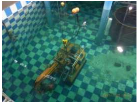
図-4.15 水槽内既設物
