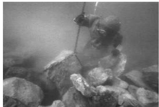
図-2.1 マウンド荒均し作業（±300mm）
