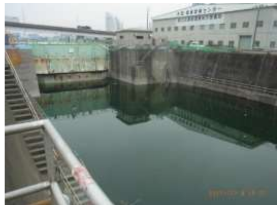
図-4.28 関東地方整備局 京浜港工事事務所ケーソン製作ドック (京浜港ドック)
