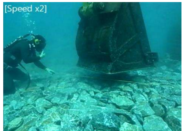
図-2.3 潜水士による丁張作業
