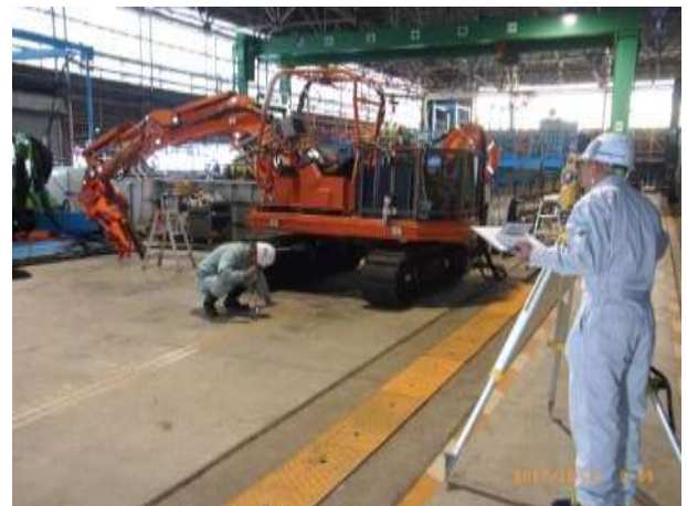
図-4.21 コンクリート面測量状況
